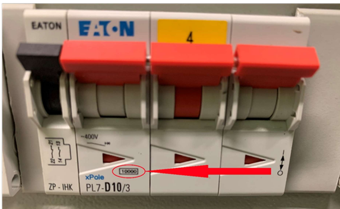
Joonis 5.3 Kaitselüliti (MCB) katkestusvõimega 10 kA (10000 A) ,
