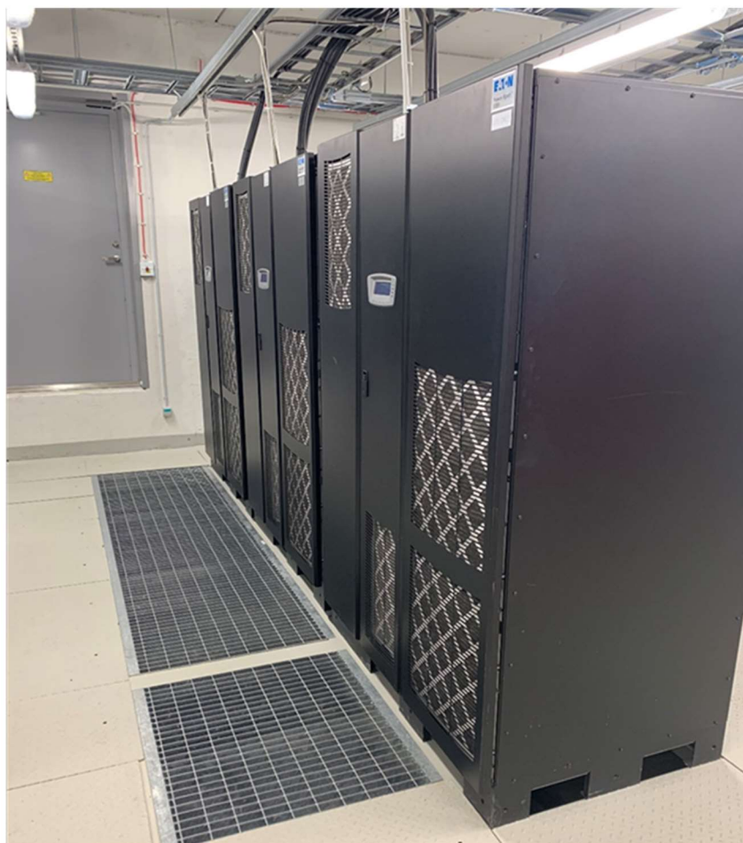
Joonis 4.5 Mustamäe haigla C korpuse UPS-i jahutamine (3 * 275 kVA paralleelselt)
