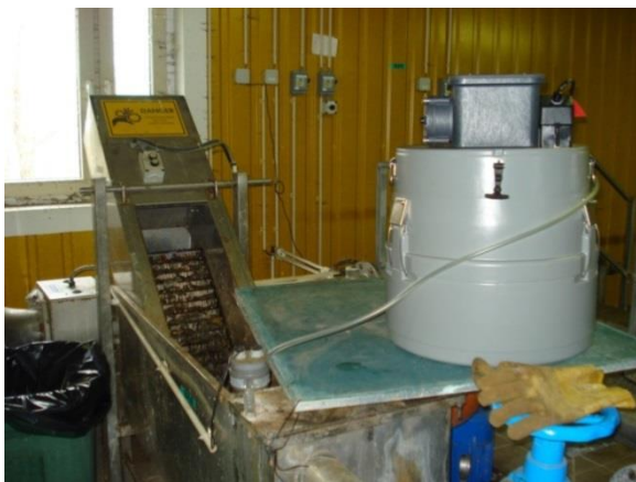
Joonis 3.2. Proovivõtuseade „3700 Standard Portable Sampler,“ asetatud treppvõre peale
