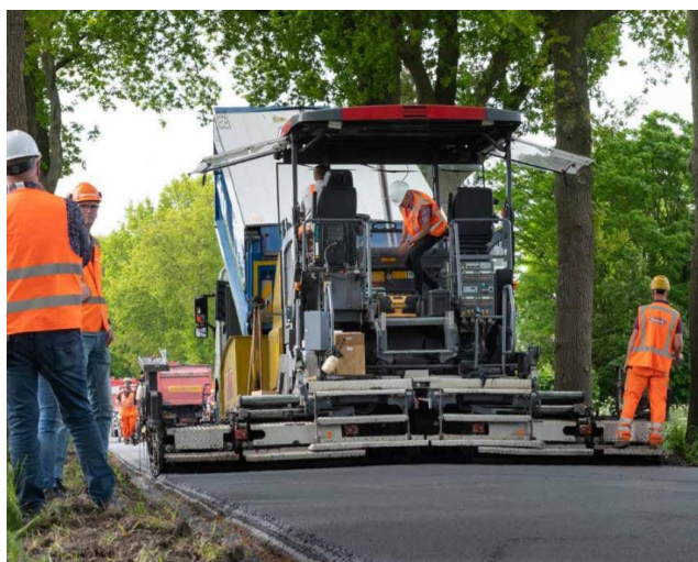
Joonis 2.4 Ligniini põhise asfaltiga testlõik N987 Siddebureni ja Wagenborgeni vahel [12]
