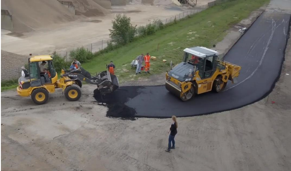
Joonis 2.8 B2Square asfalditootmistehase tee asfalteerimine 100 % biopõhistel komponentidel põhineva biobituumenist asfaltseguga [51]
