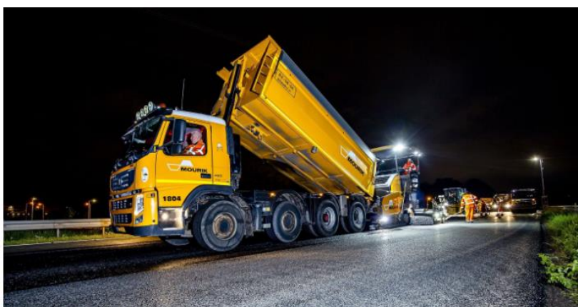
Joonis 2.7 Harsfalti (vaikasfalt) paigaldamine [55]
