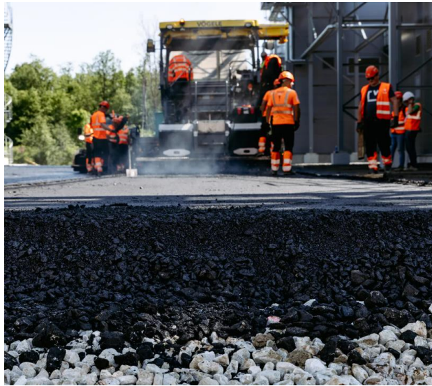
Joonis 2.6. Fibenoli tehaseplatsile paigaldatav ligniinipõhise komponendiga biobituumenist toodetud bioasfaltsegu [57]
