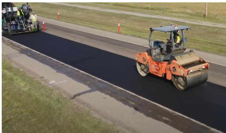
Joonis 2.5 Kanadas ligniinipõhise asfaltsegu paigaldamine [13]
