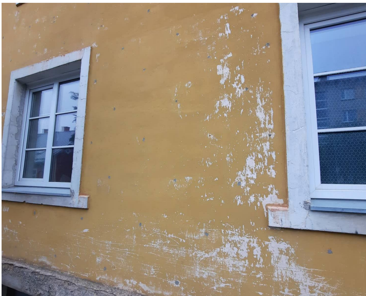
Joonis 3.1 Tartu 34a välisseinas PUR vahu süstimisavad
