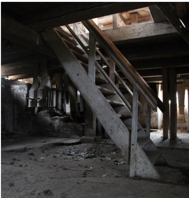
Pilt 33. Vajunud betoonpõrand
