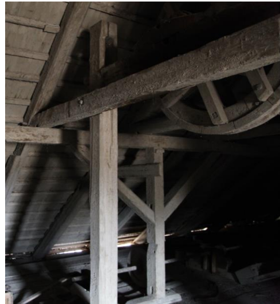
Pilt 9. Katuse kandekonstruktsioon
