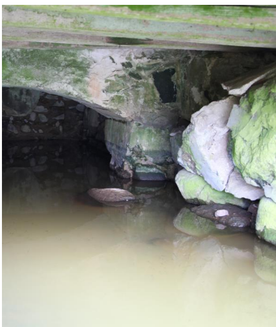
Pilt 40. Varisenud veekanalite sein
