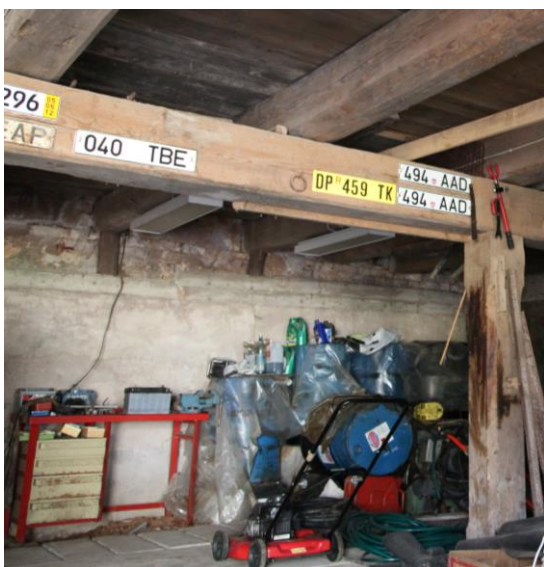
Pilt 24. Garaaži vahelagi, betoonist tugisein
