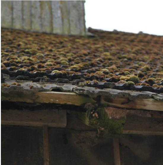
Pilt 17. Veskiosa betoonkivikatus
