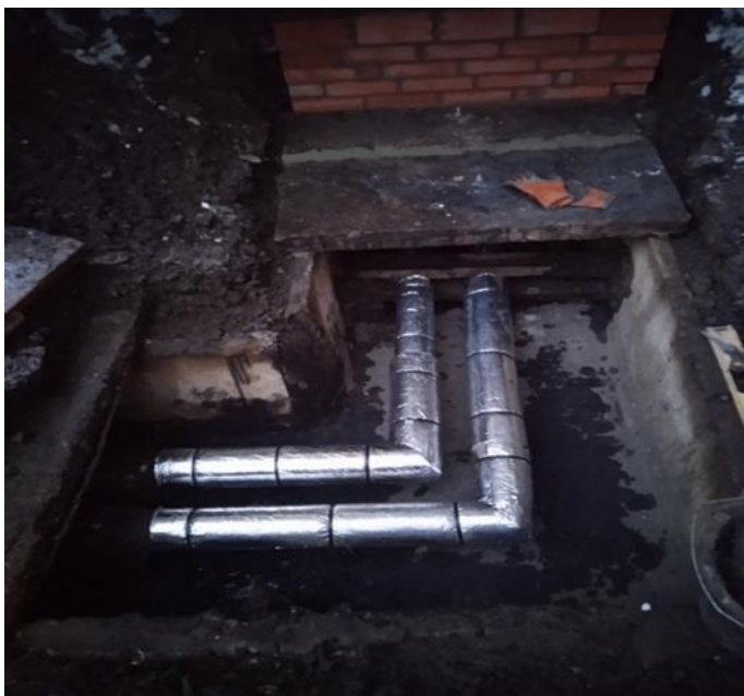
Joonis.1.6. Paigaldus meetod, toru kanalis
