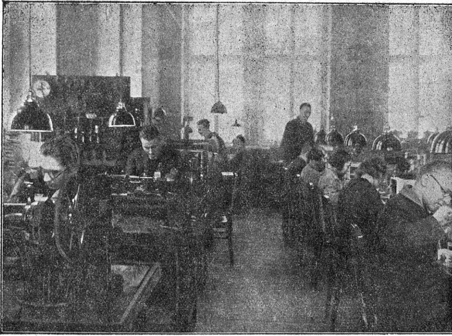
Vaade RET-i monteerimisruumi. Vasemal treipingid, paremal osa monteerimis-lauast.
