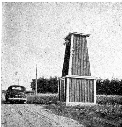
Joon. 6. Trafo-alajaam. Puitkiosk.
