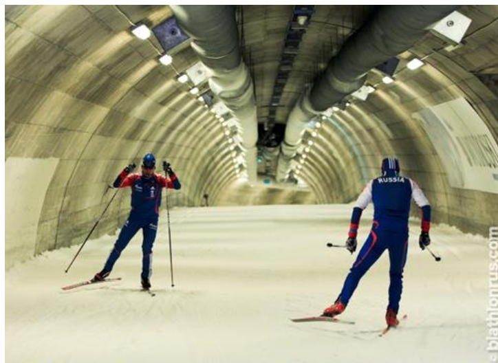
Joonis 5. Suusatunnel Vuokatti Soomes. Tunneli parameetrid: pikkus – 1210 m, laius – 8 m, kõrgus – 4 m, temperatuur - -5...-9 C. [1]
