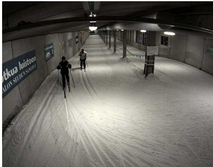
Joonis 7. Suusatunnel Paimio Soomes. Tunneli parameetrid: pikkus – 700 m, laius – 6 m, kõrgus – 4 m, temperatuur – -3 C. [12]
