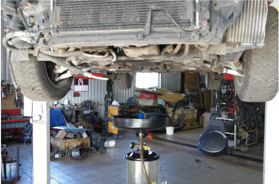
Joonis 2.2 Mootoriõli eemaldamine
