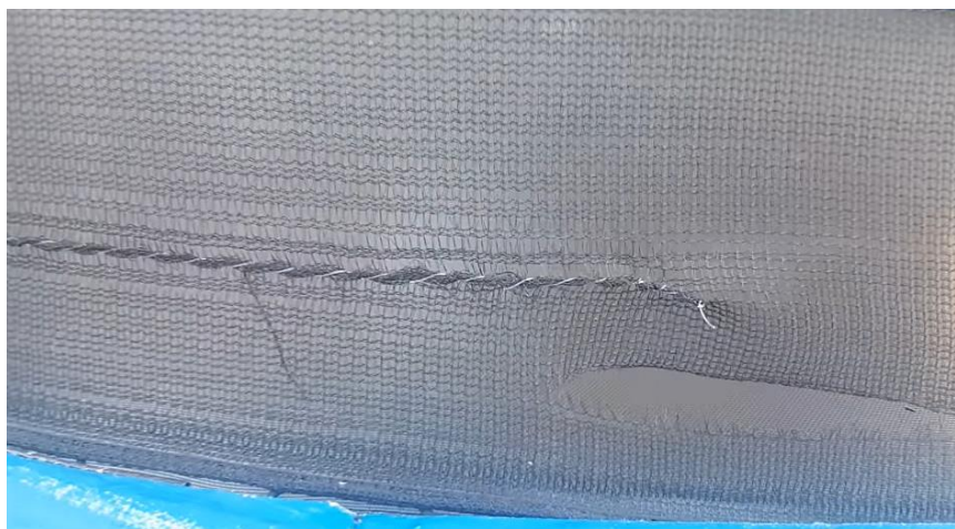
Joonis 6.3 Materjali pingutamine auguga ala katmiseks - illustratsioon
