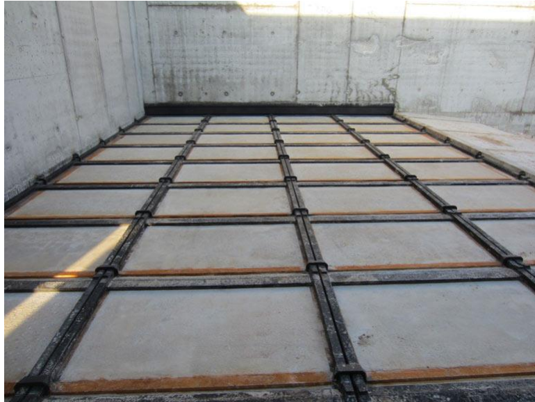
Joonis 1.6 Liikuvpõrand nelja roobiga [9]
