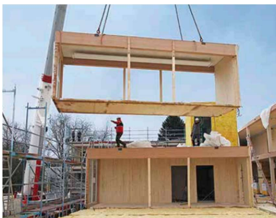
Joonis 1.6 Avatud moodul montaaži ajal ja joonis 1.7 Lõpptulemus Objekt: Euroopa Kool Frankfurdis, Saksamaal. Allikas [11]
