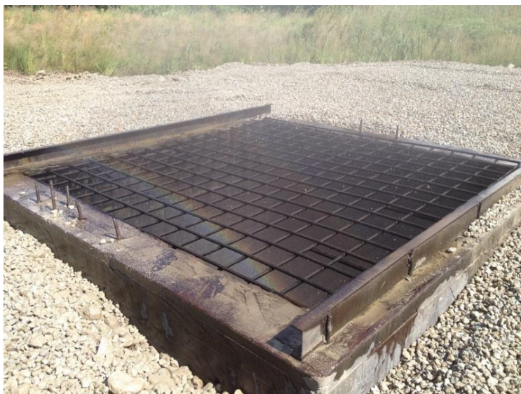
Joonis 14. Puur-lõhketöödega rajatud šurfi kaitsevõre [EEK] mitte alla 2 m. Lisaks tuleb šurfi ümbrus 2 m raadiuses ääristada 1,1 m kõrguse barjääriga ja paigaldada barjäärile nähtavalt ohutuslint, et vältida inimeste ja loomade juhuslikku sattumist šurfi läbindamise perioodil. Tööde lõpetamisel kaetakse šurf ohutuse eesmärgil metallvõre (vt Joonis 14).
