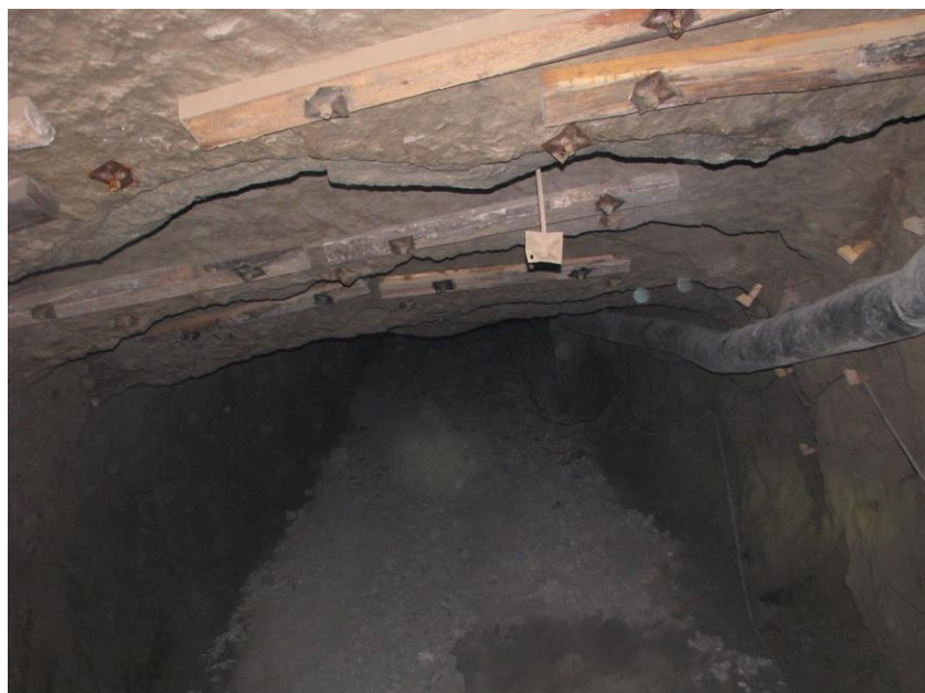
Joonis 8. Vaade šurfi kaldosale kaeveõõnest [ EEK ]
