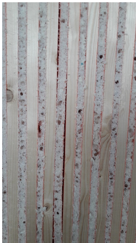
Joonis 6.1 Praod PVC teibi ja hõõveldatud laua on vahel visuaalselt näha
