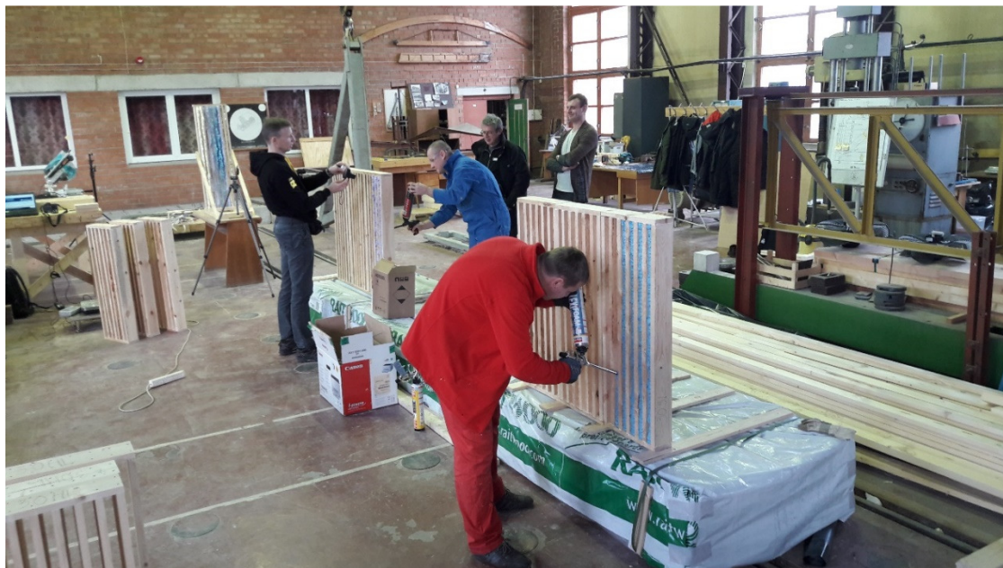
Joonis 4.4 Katsekehade ettevalmistamine ja montaaživahuga täitmine
