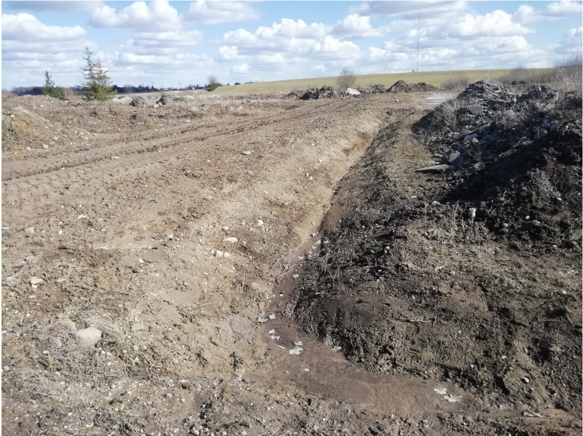
Joonis 2.5 Olemasolevast kraavist nähtav pinnase ristlõige. Aprill 2021
