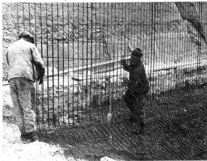
Kaitsetammide ja tugimüüride tööde juures terasmatte on lihtne asetada.
