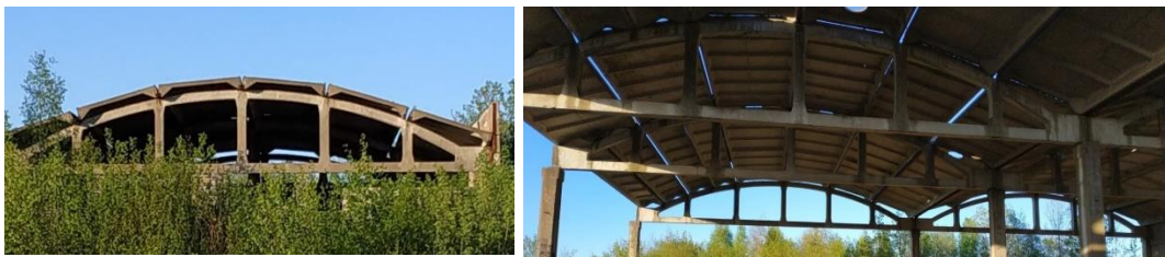
Joonis 1. Vaade olemasolevale ehitisele ja ehitise kandekonstruksioonidele. Autori fotod.
