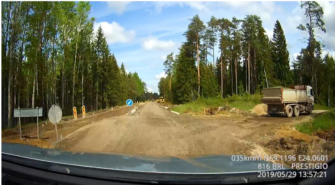
Joonis 2.22 Põikest on võimalik otse sõita. Mõõdukas rikkumine. [9]
