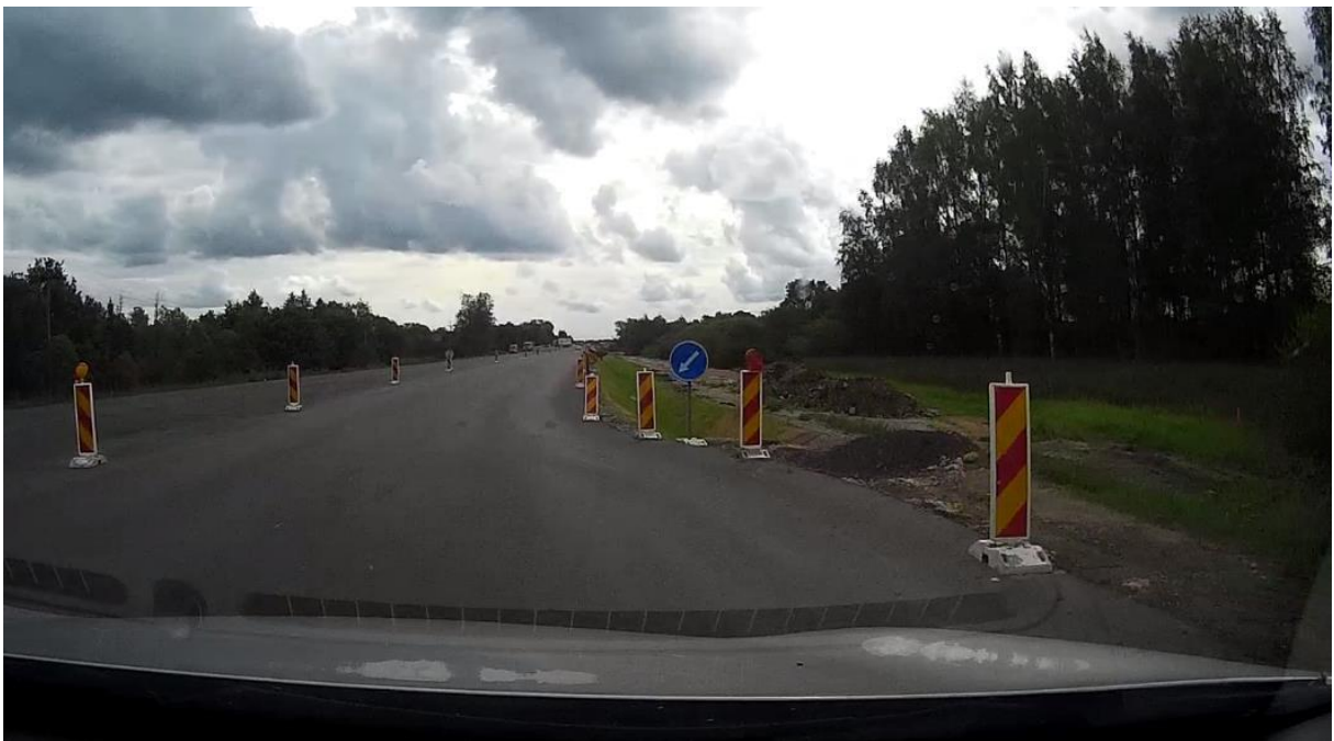
Joonis 2.10 Ebapiisav kogus lampe ja liiklusmärke põikel. Mõõdukas rikkumine. [7]
