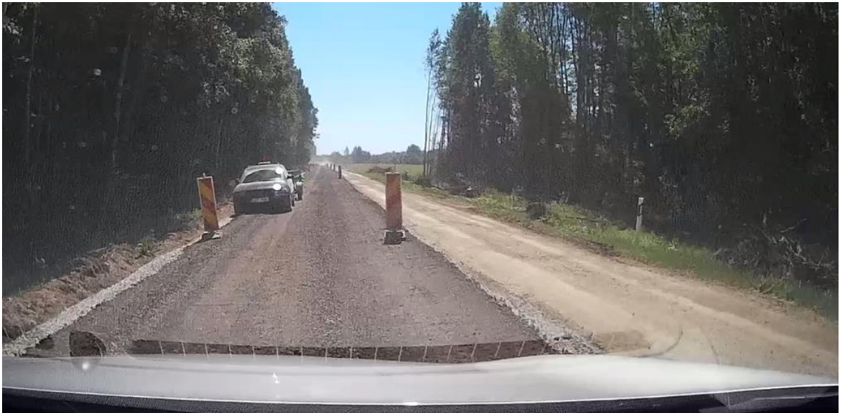
Joonis 2.16 Ühele sõidurajale satuvad korraga mõlemas suunas liiklejad. Raske rikkumine. [7]
