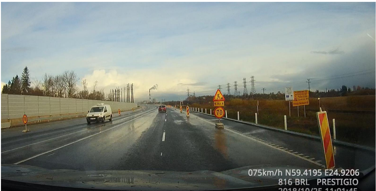
Joonis 2.5 Püsiv teekattemärgistus on tehtud, kuid ajutiselt on kogu liiklus suunatud ühele sõidurajale. Punane sõiduk paikne selles olukorras juba osaliselt vastassuunavööndis. [7]
