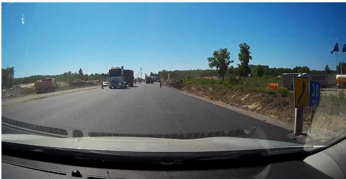
Joonis 2.1 Liiklus kanaliseerimata, liikleja ei saa teel paiknemisest aru. Raske rikkumine. [7]
