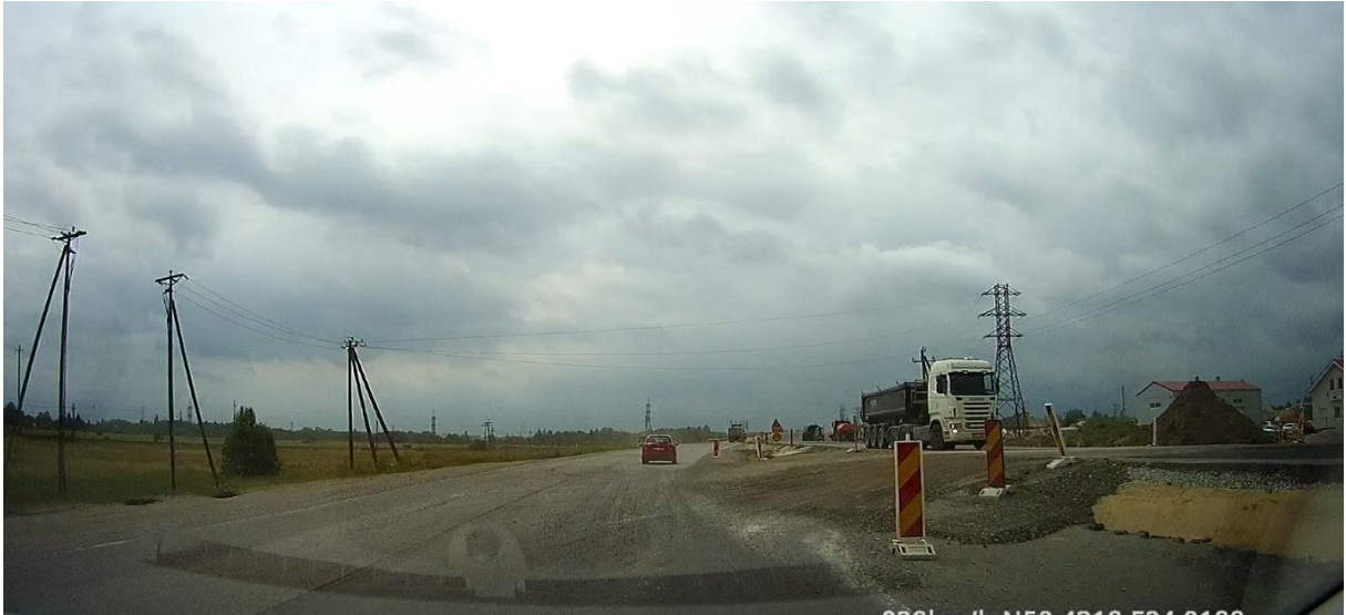
Joonis 2.9 Asfalteerimata avalikuks kasutamiseks mõeldud põige, lahtine materjal teel. Sõidusuunad kanaliseerimata, eesõiguse märgid puudu. Raske rikkumine. [7]
