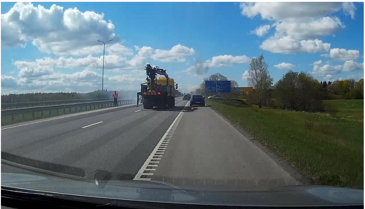
Joonis 2.14 Sõiduradade omavoliline sulgemine. Raske rikkumine. [7]
