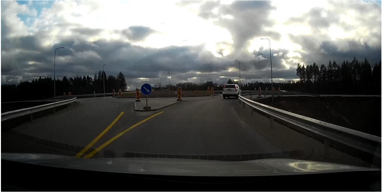
Joonis 2.11 Ringristmikul puuduvad ringristmiku ja kohustusmärgid. Raske rikkumine. [7]
