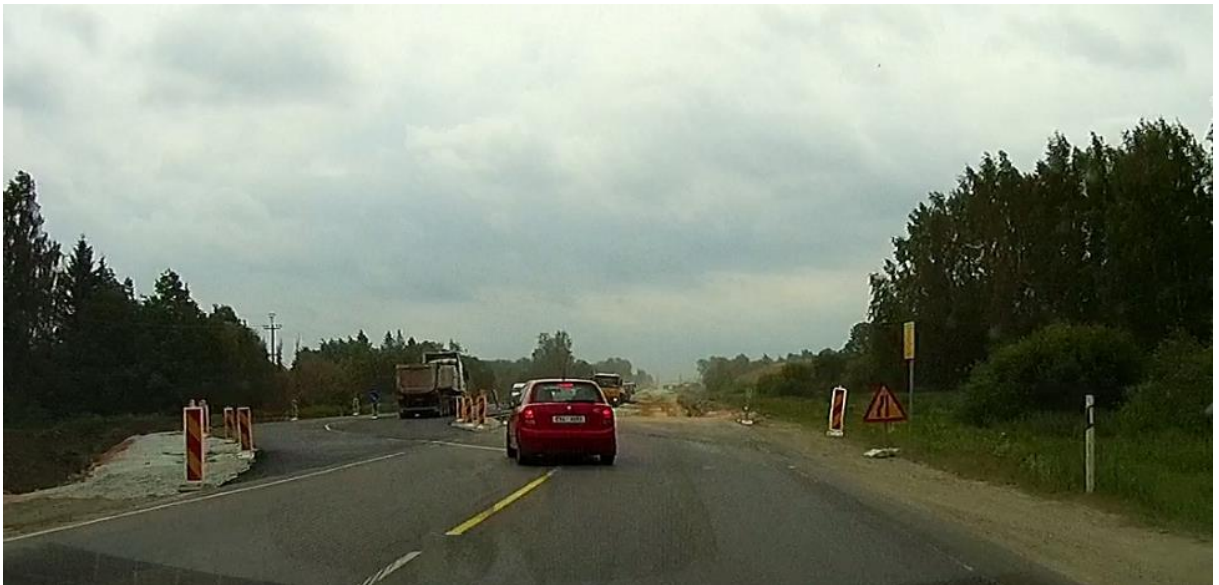
Joonis 2.8 Põigetal puuduvad liiklusmärgid ja hoiatustarad, võimalik sõita otse töömaale. Kasutusel vale liiklusmärk 163. Raske rikkumine. [7]
