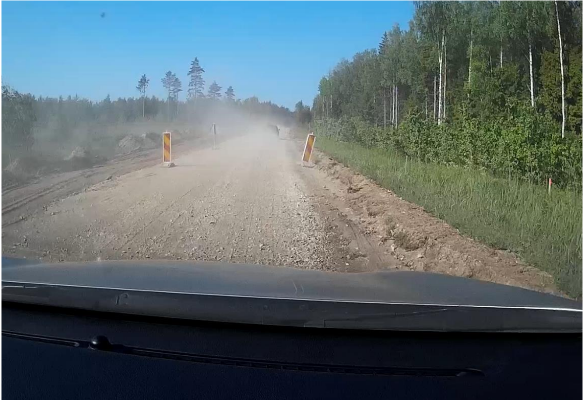
Joonis 2.20 Tee ristlõikes ei ole tagatud piisav laius. Tee tolwab, vastutulevaid autosid ei ole näha. Raske rikkumine. [9]
