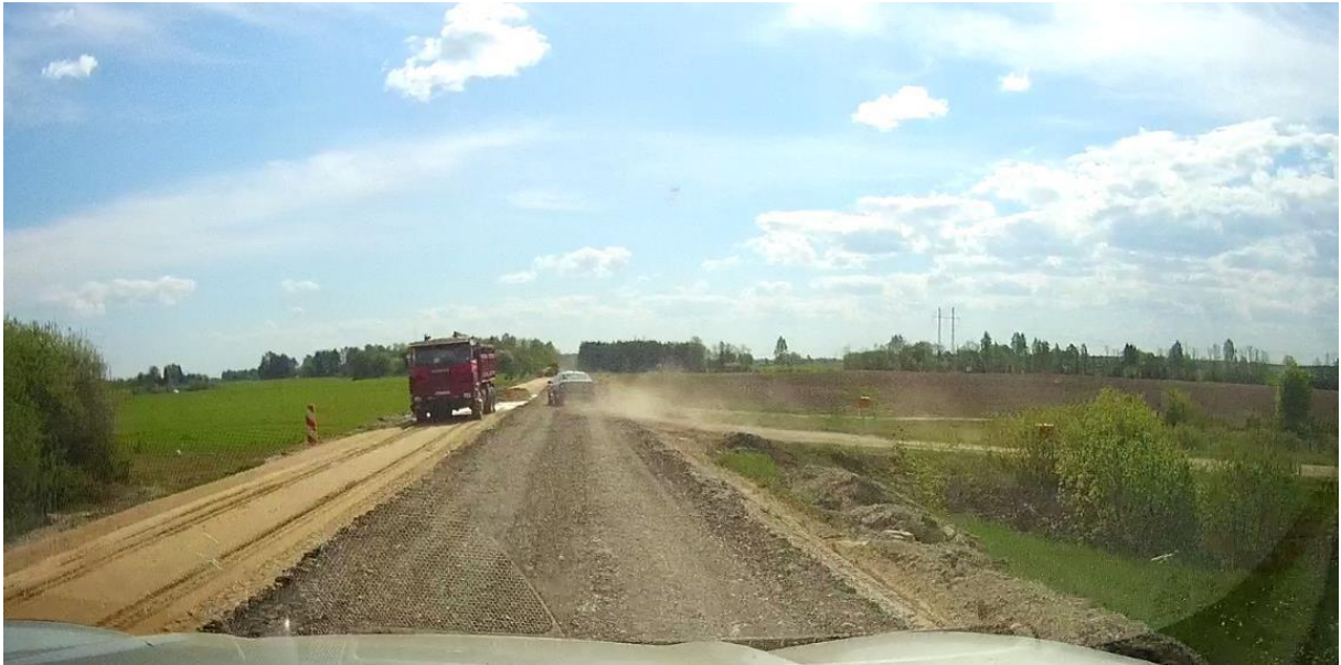
Joonis 2.23 Töötsoon eraldamata. Mõõdukas rikkumine. [7]
