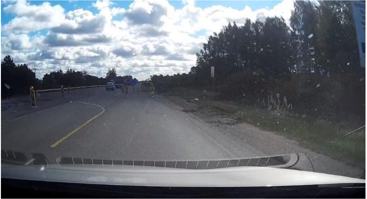
Joonis 2.7 Ajutine markeering juhatab valesti. Mõõdukas rikkumine. [7]
