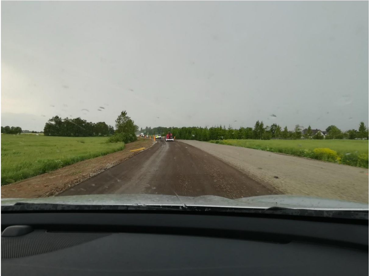
Joonis 2.18 Töötsoon eraldamata. Oht sattuda töömaale. Mõõdukas rikkumine. [7]
