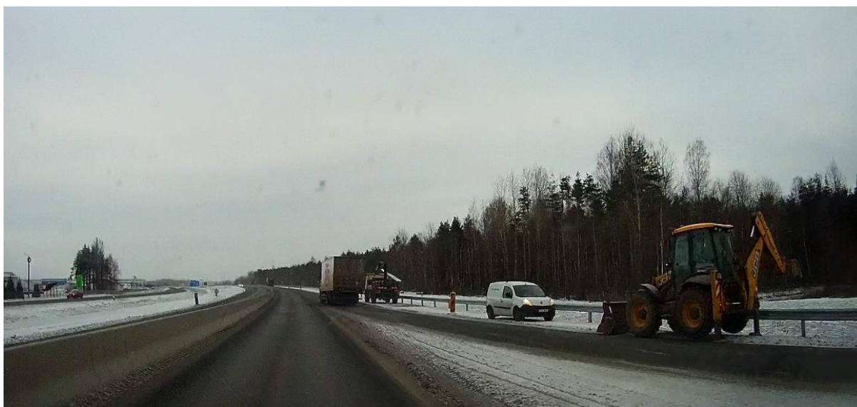
Joonis 2.2 Teetööde masinad on tähistamata ning ei kasuta vilkureid. Mõõdukas rikkumine. [7]
