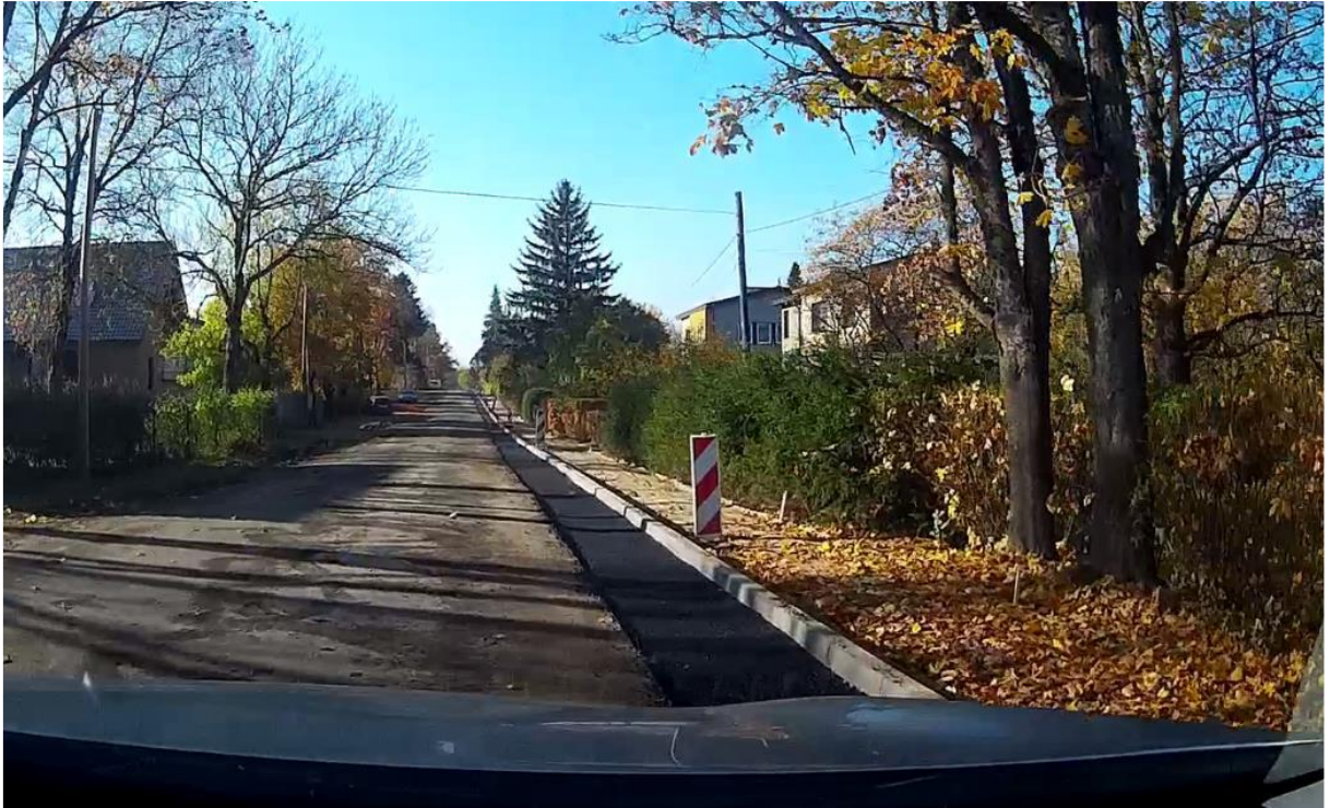
Joonis 2.27 Kasutatakse puna-valgeid 686-i, aga peaksid olema puna-kollased. Töötsoon, astmed ja ohtlikud kohad tähistamata. Mõõdukas rikkumine. [7]
