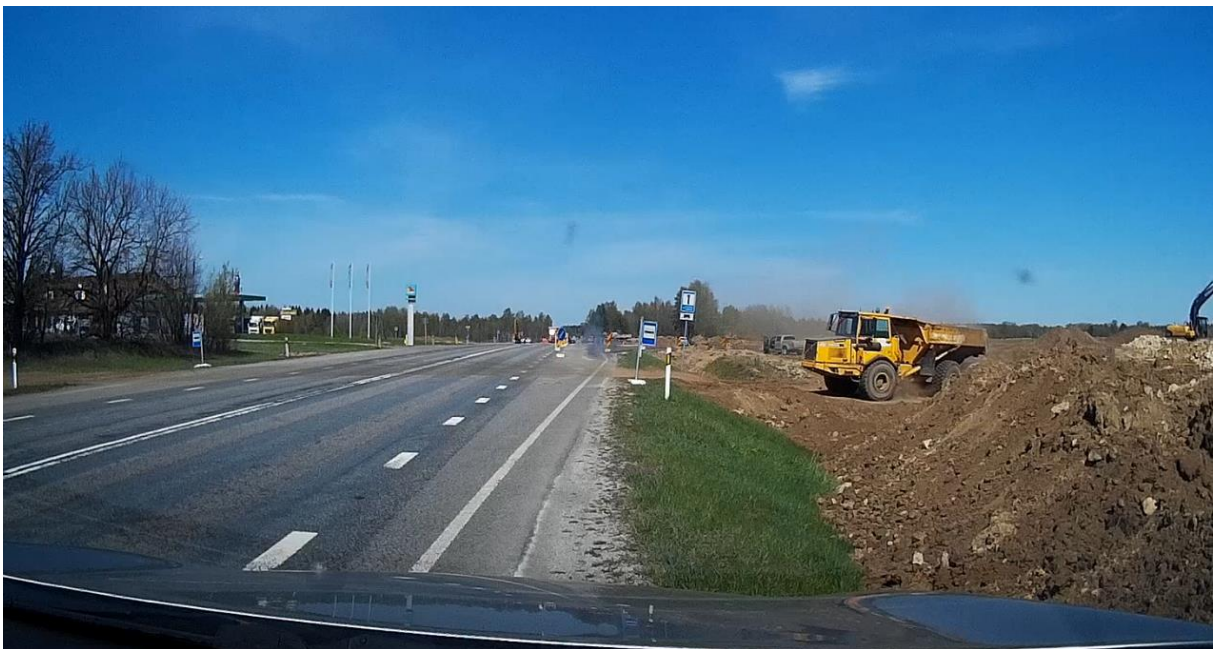
Joonis 2.12 Bussipeatus on objekti mahasõidul. Ei ole tagatud piisav nähtavus ega reisijate ohutus. Raske rikkumine. [7]
