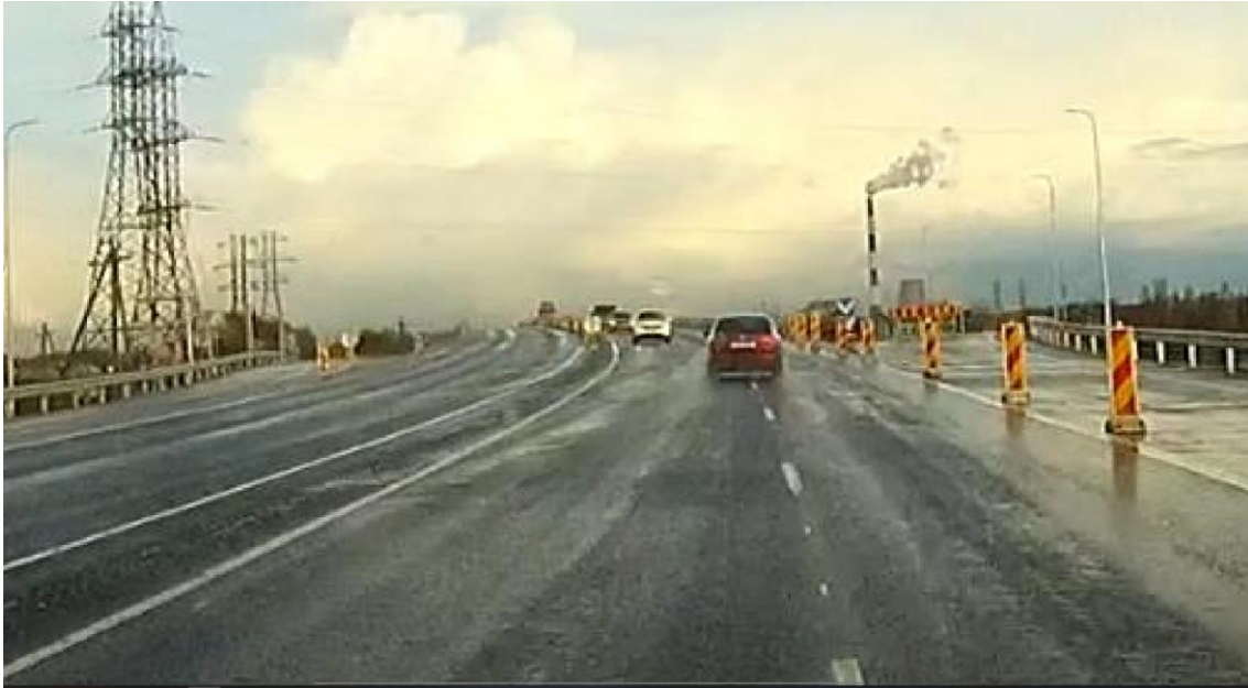
Joonis 2.5 Püsiv teekattemärgistus on tehtud, kuid ajutiselt on kogu liiklus suunatud ühele sõidurajale. Punane sõiduk paikne selles olukorras juba osaliselt vastassuunavööndis. [7]
