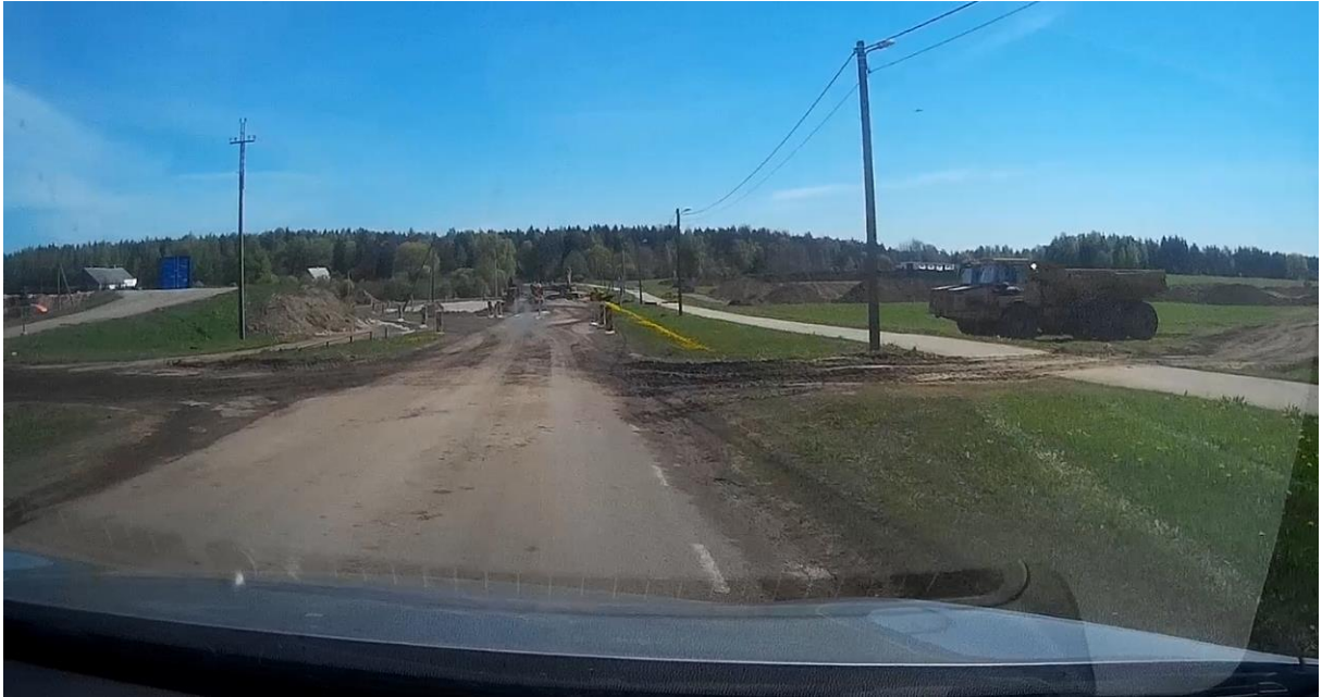
Joonis 2.13 Teekate puhastamata. Kerge rikkumine. [7]
