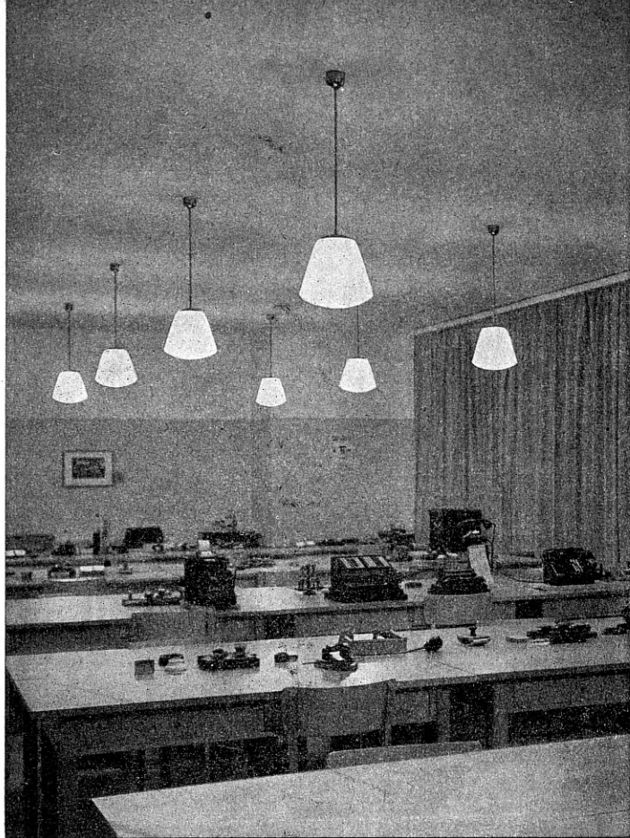
Joon. 2. Ülekaalukalt allakiirguvate valgustuskehadega (sügavkuplitega) korralikult valgustatud bürooruum.
