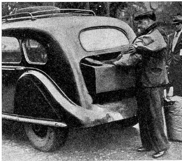
Joon. 8. Kastikujuline gaasigeneraator Pariisi taksoautol. Juht parajasti täidab seda põletisega.
