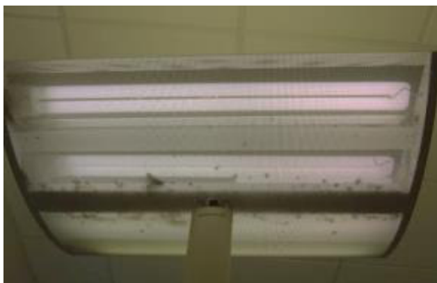
Joonis 2.38. Näide valgusti määrdumisest kontoritingimustes ja LMF-i sõltuvusest määrdumisastmest IP2x valgusti korral (CIE 154:2003 järgi) [36]
