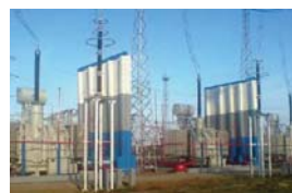
Uuel aastatuhandel on valminud juhitavad reaktorid pingetele 110, 220, 330 ja 525 kV. Lähim neist paikneb Leedus
