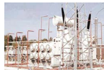
Uuel aastatuhandel on valminud juhitavad reaktorid pingetele 110, 220, 330 ja 525 kV. Lähim neist paikneb Leedus
