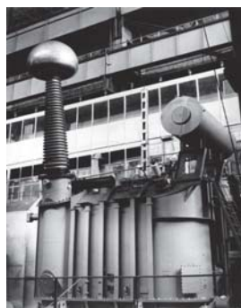
Esimene ainulaadne 525 kV juhitav reaktor Žaporožjes 1992. a
