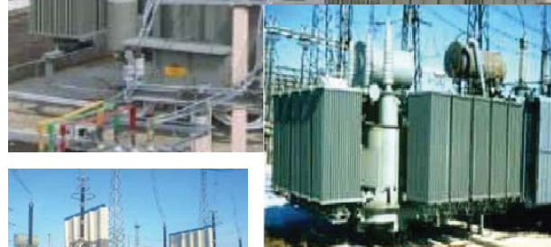
Uuel aastatuhandel on valminud juhitavad reaktorid pingetele 110, 220, 330 ja 525 kV. Lähim neist paikneb Leedus
