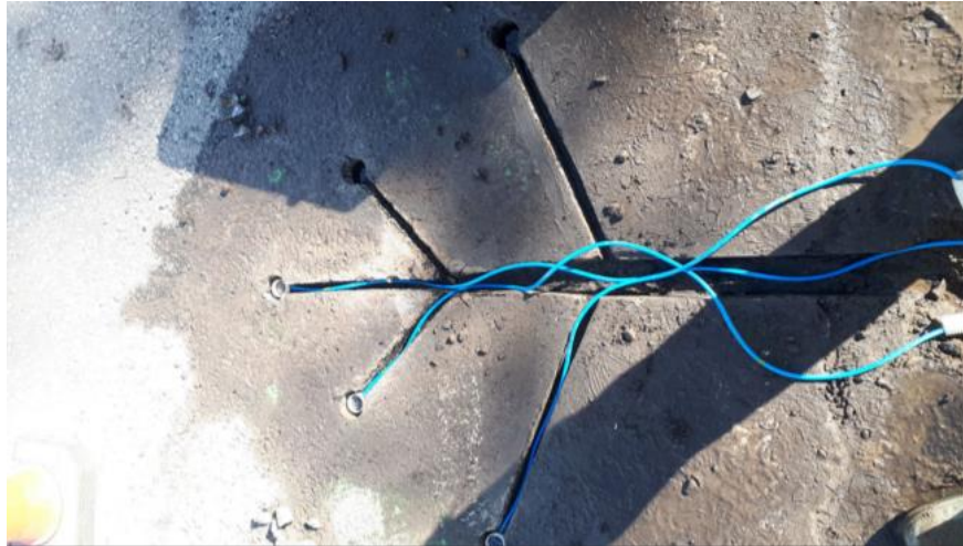
Joonis 7.4 Teepinna sisse paigaldatud kontaktmikrofonid ja juhtmed [35]
