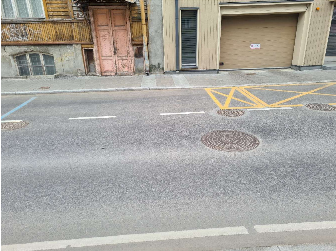
Lisa 4 Joonis 3 J.Poska tn maja nr 29 ees olevad kaevud (väiksem kaev on Vergumix Bitulan meetodil parandatud)
