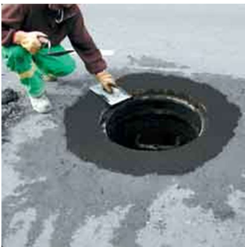
Lisa 2 kaevu parandamine Vergumix Bitulan AC või analoog tehnoloogial
