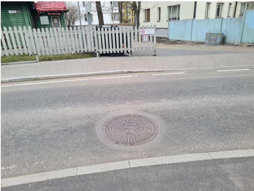
Lisa 5 Joonis 4 J.Poska tn maja nr 19 ees olev kaev on Vergumix Bitulan meetodil parandatud
