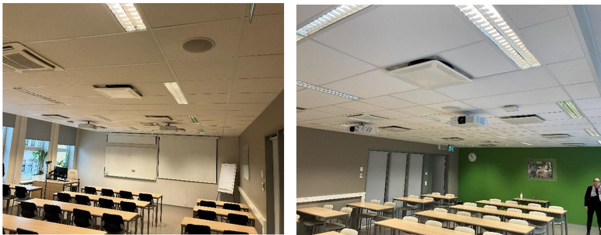
Joonis 1. Auditoorium U06-304, akna pool neli sissepuhke ja seina pool neli väljatõmbe õhujaotajat
