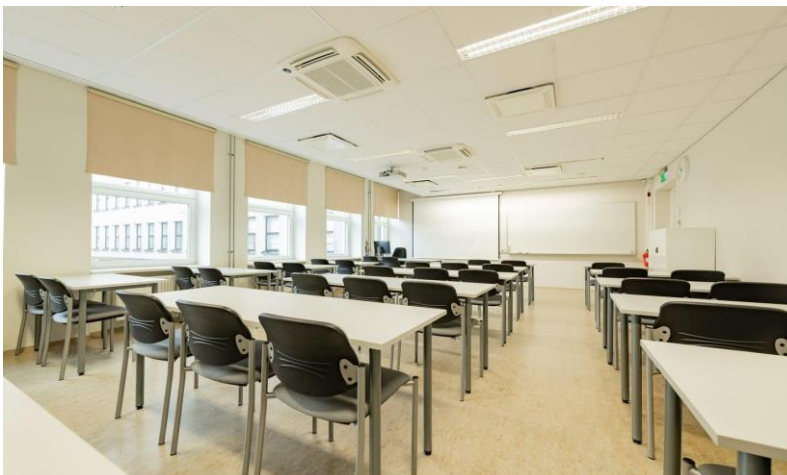
Joonis 7. U05-105, akende pool väljatõmbe ja seina pool sissepuhke õhujaotajad [21]
