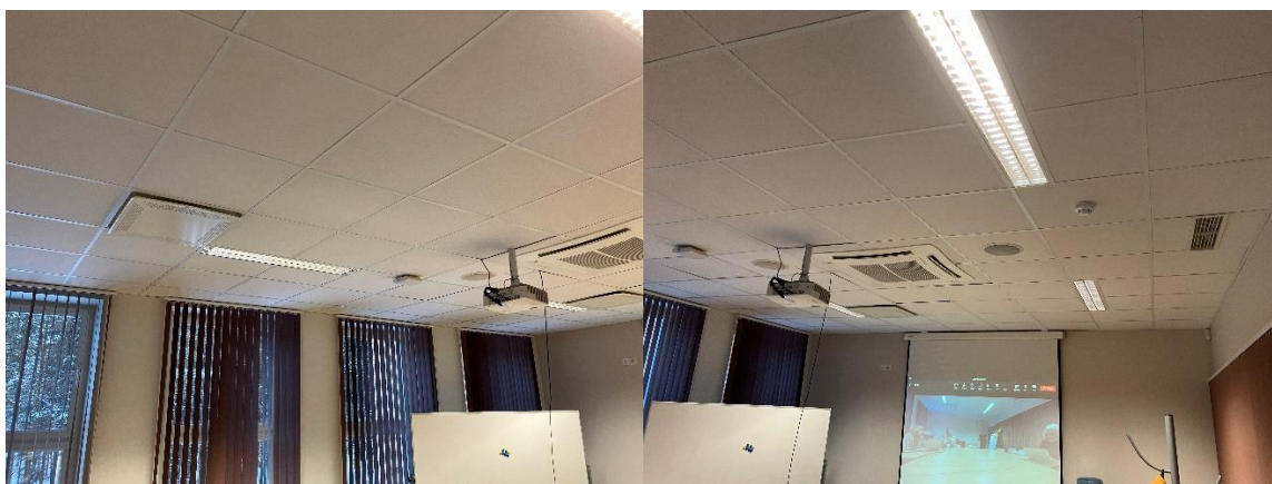
Joonis 2. Koosolekuruum U06-222, akna pool kaks sissepuhke õhujaotajat ja seina pool väljatõmberest
