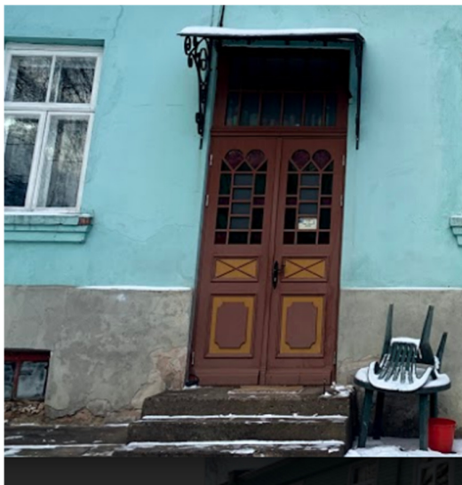
Joonis 4.4 Niiskuskahjustus uksest vasakul. (autori foto nr. 001)
