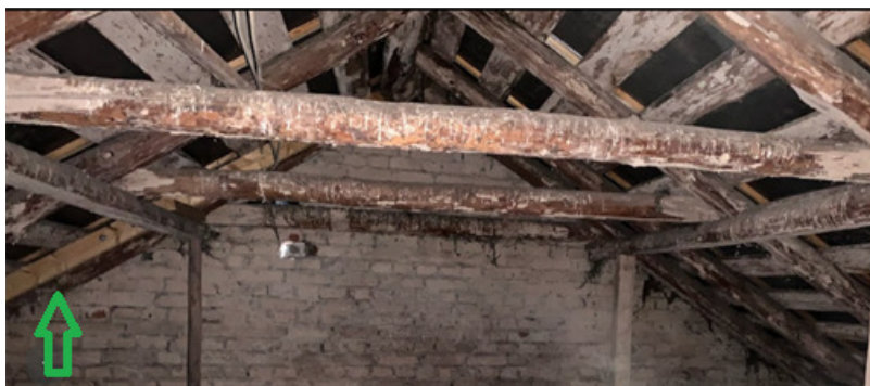
Joonis 4.19 Teljel 6 tugevdatud sarikas. (autori foto)
