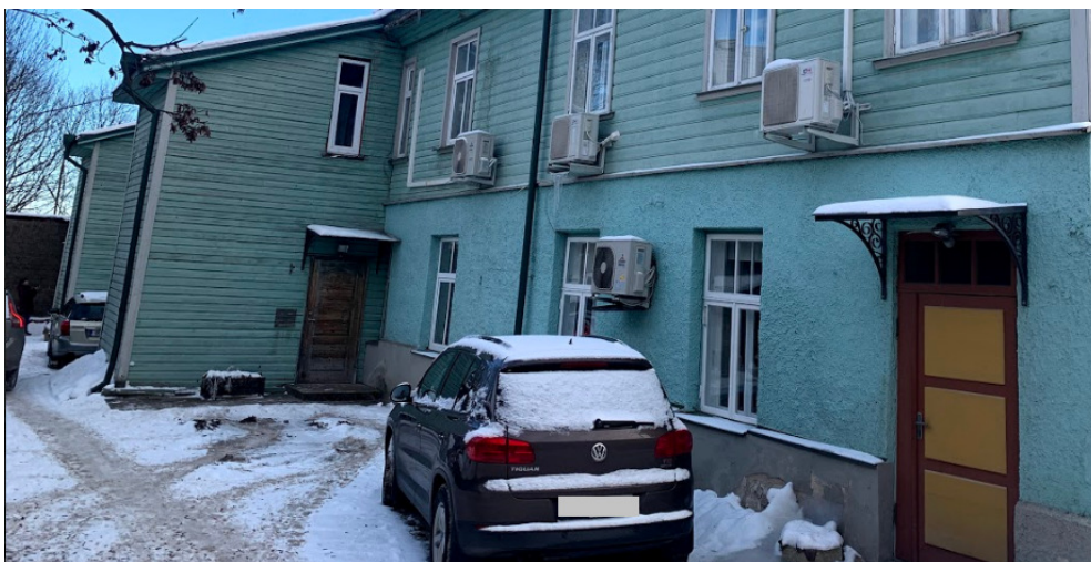
Joonis 4.7 Lumevallid sokli kõrval, teljel B ja madal sokke teljel 1. (autori foto nr. 004)
