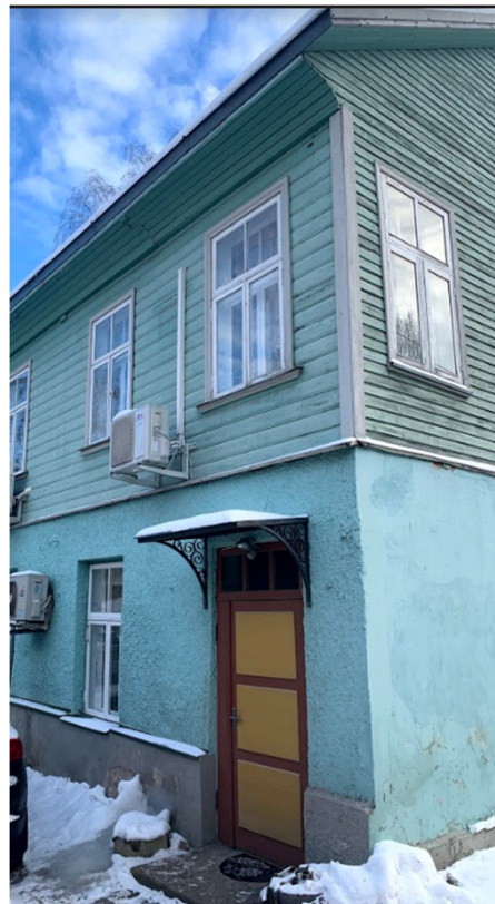
Joonis 4.7 Lumevallid sokli kõrval, teljel B ja madal sokke teljel 1. (autori foto nr. 004)
