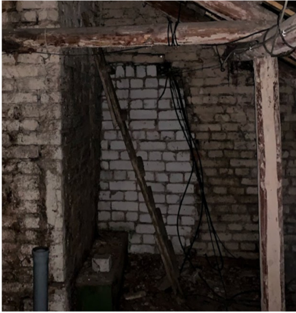
Joonis 4.21 Suletud ava tulemüüris, teljel 3. (autori foto)
