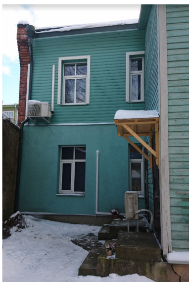
Joonis 4.15. Telgede 5 ja 6 vahelisel alal välisseina lisatud soojustus. (autori foto nr. 011)
