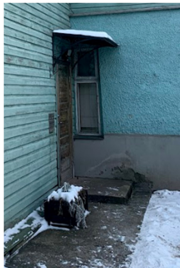
Joonis 4.5 Niiskuskahjustused soklil. (autori foto nr. 006)
