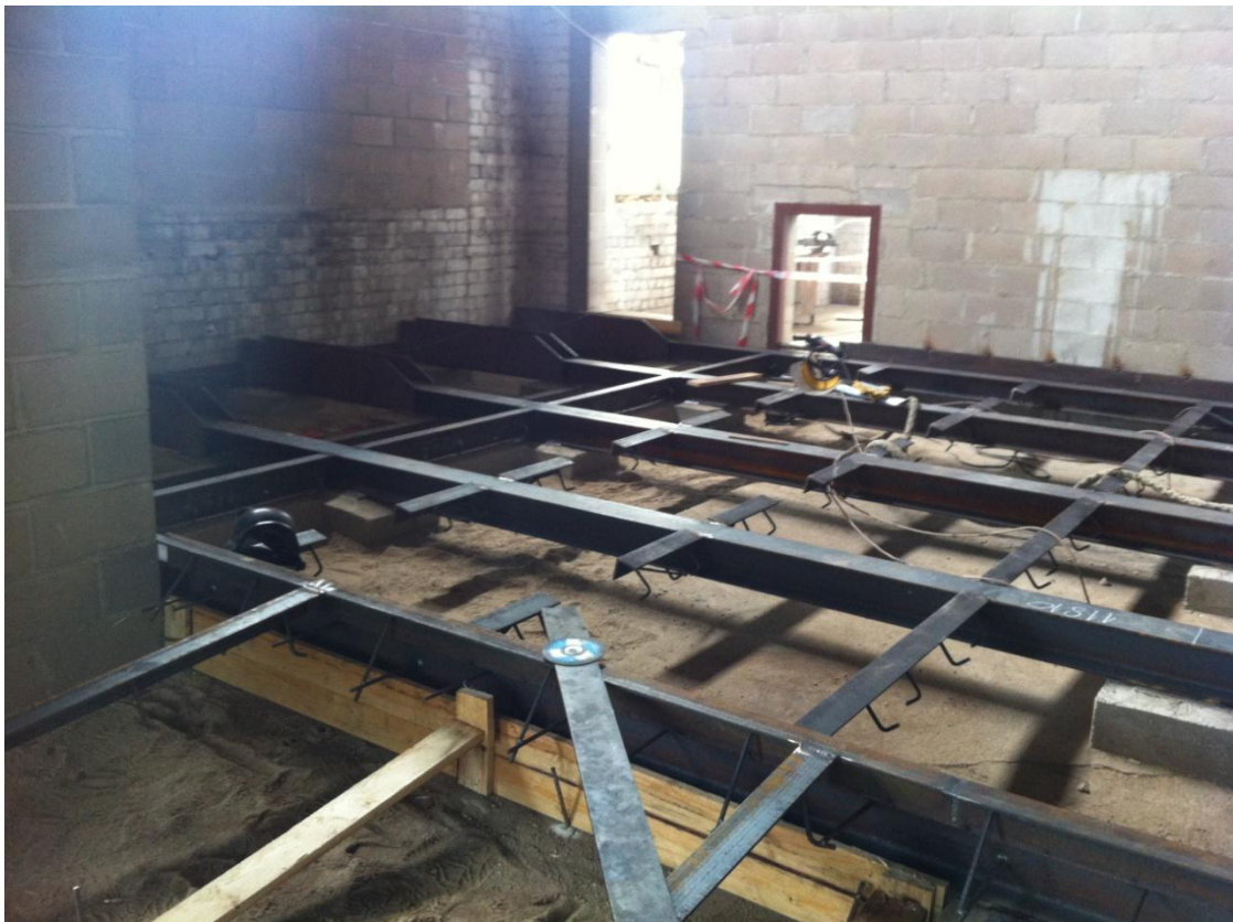
Sele 2.1.1 Lao mehhaniseeritud osa paigaldus betooni sisse
