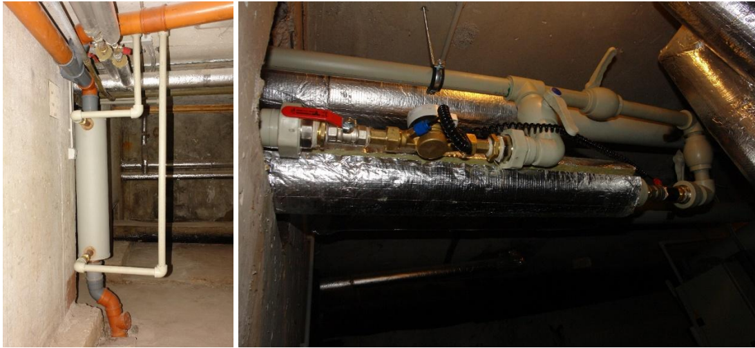
Joonis 17 Vilde tee korterelamu kesksoojusvaheti kanalisatsioonipistikul verikaalselt paigaldatuna (vasakul) (allikas: tootja foto). Soojusmõõtja süsteemi efektiivsuse mõõtmiseks külmaveetorul (paremal) (allikas: tootja foto)
