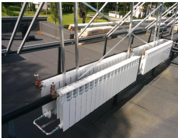
Joonis 10 Päikesekollektor (vasakul) (allikas: http://paikesepaneel.ee/Web/Paikesekollektorid ). Radiaatorid kasutamata liigsoojusest vabanemiseks (paremal) (55)
