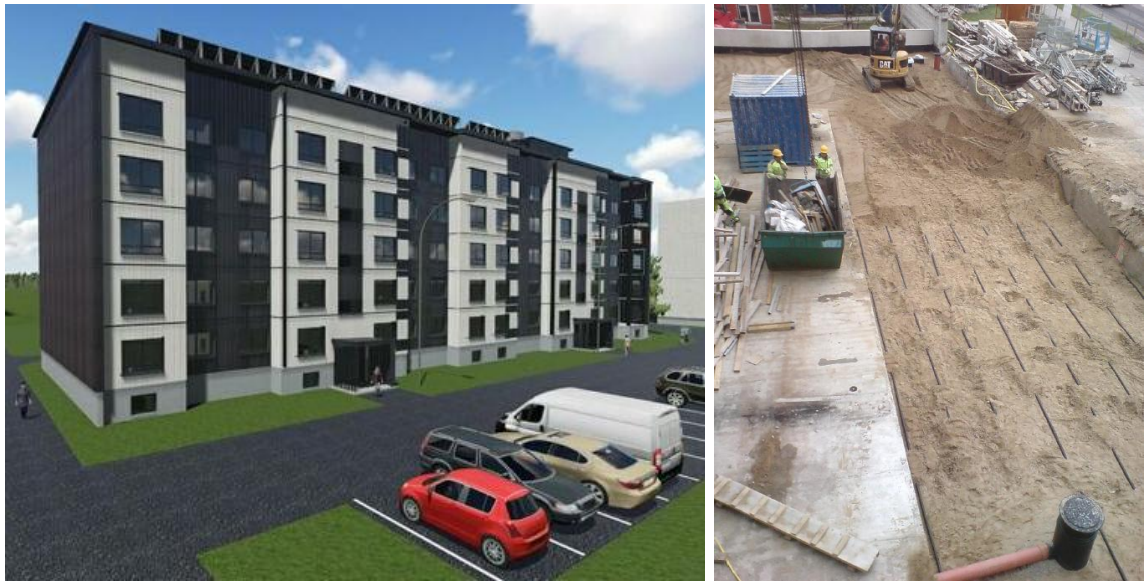
Joonis 19 TTÜ liginullenergia ühiselamu arhitektuuribüroo Sirkel & Mall OÜ eskiis (vasakul) (60). Superministeeriumi maaküttekollektor (paremal) (61)
