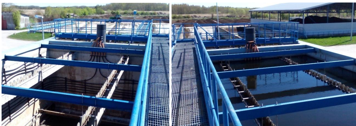
Joonis 20 Haapsalu reoveepuhastusjaam viimase settebasseini maaküttekollektorid veega täitmata (vasakul) ja veega täidetud (paremal) olekus (allikas: autori fotod)
