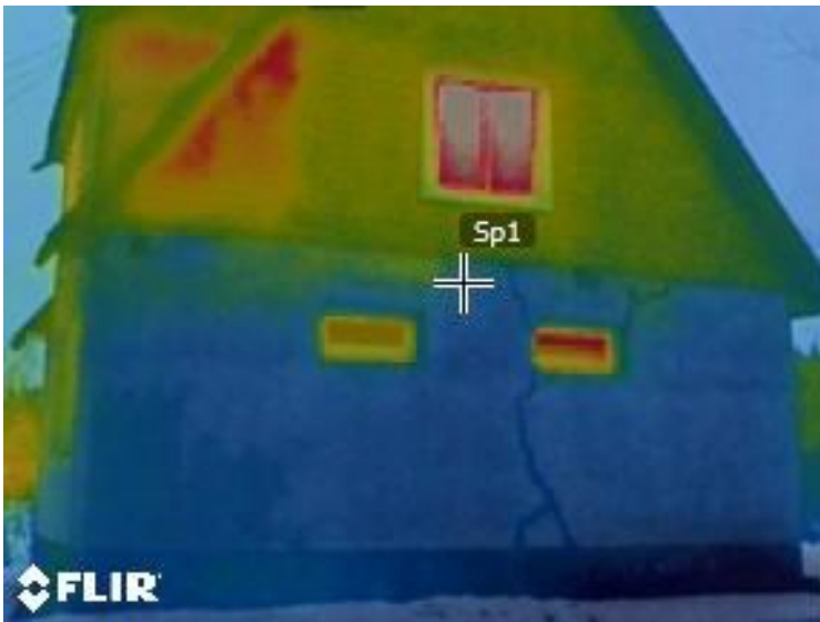
Termofoto 1. Hoone kagukülg
