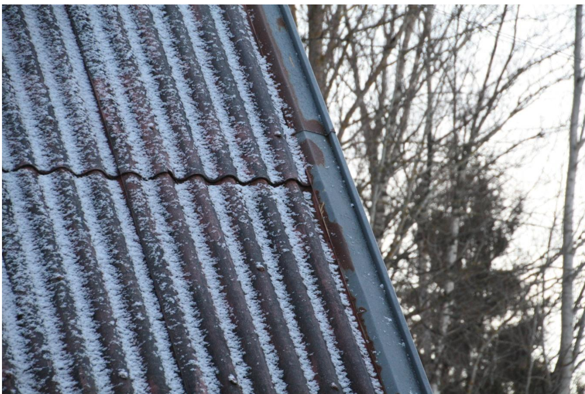
Foto L1. 10. Pindmise roostekihiga katuseplekid
