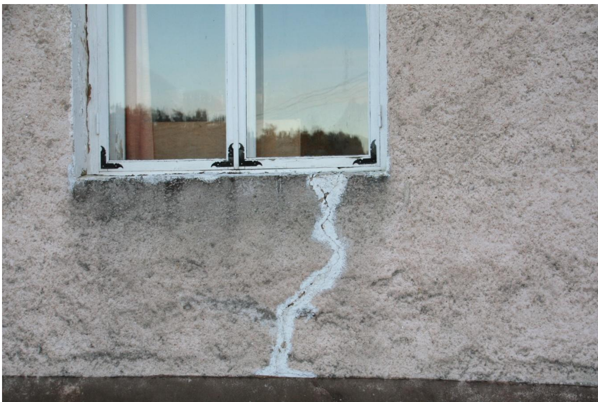
Foto L1. 2. Peened mõrad I korruse välisseinal, kohati koorunud aknavärv
