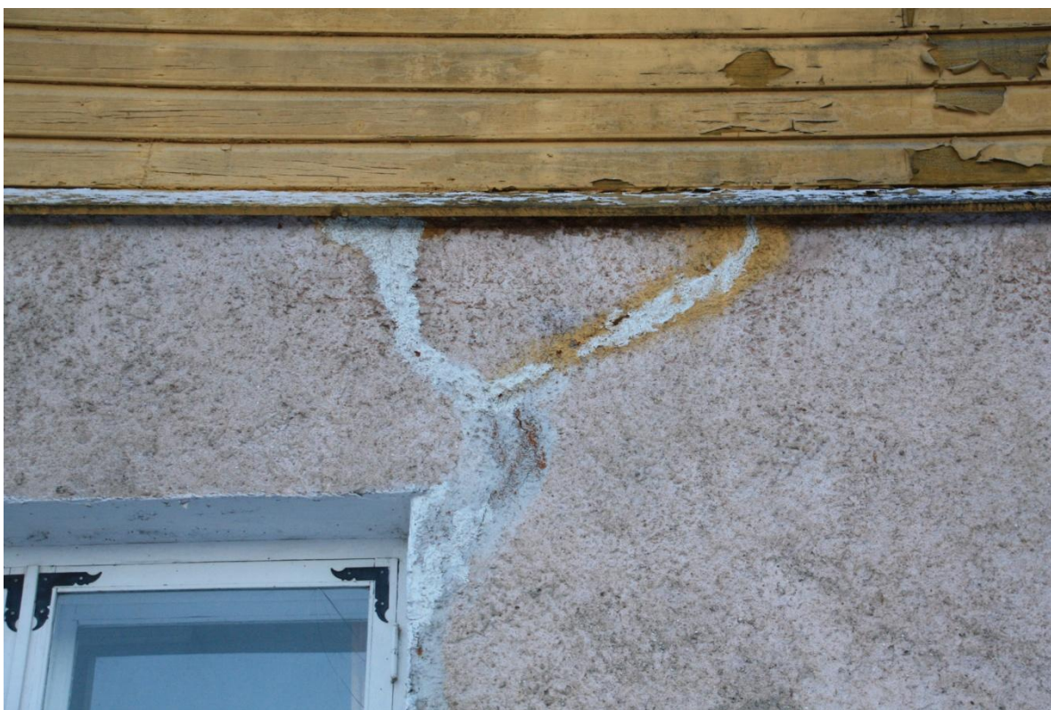
Foto L1. 3. Peened mõrad I korruse seinal, koorunud värv katuseviilu laudisel
