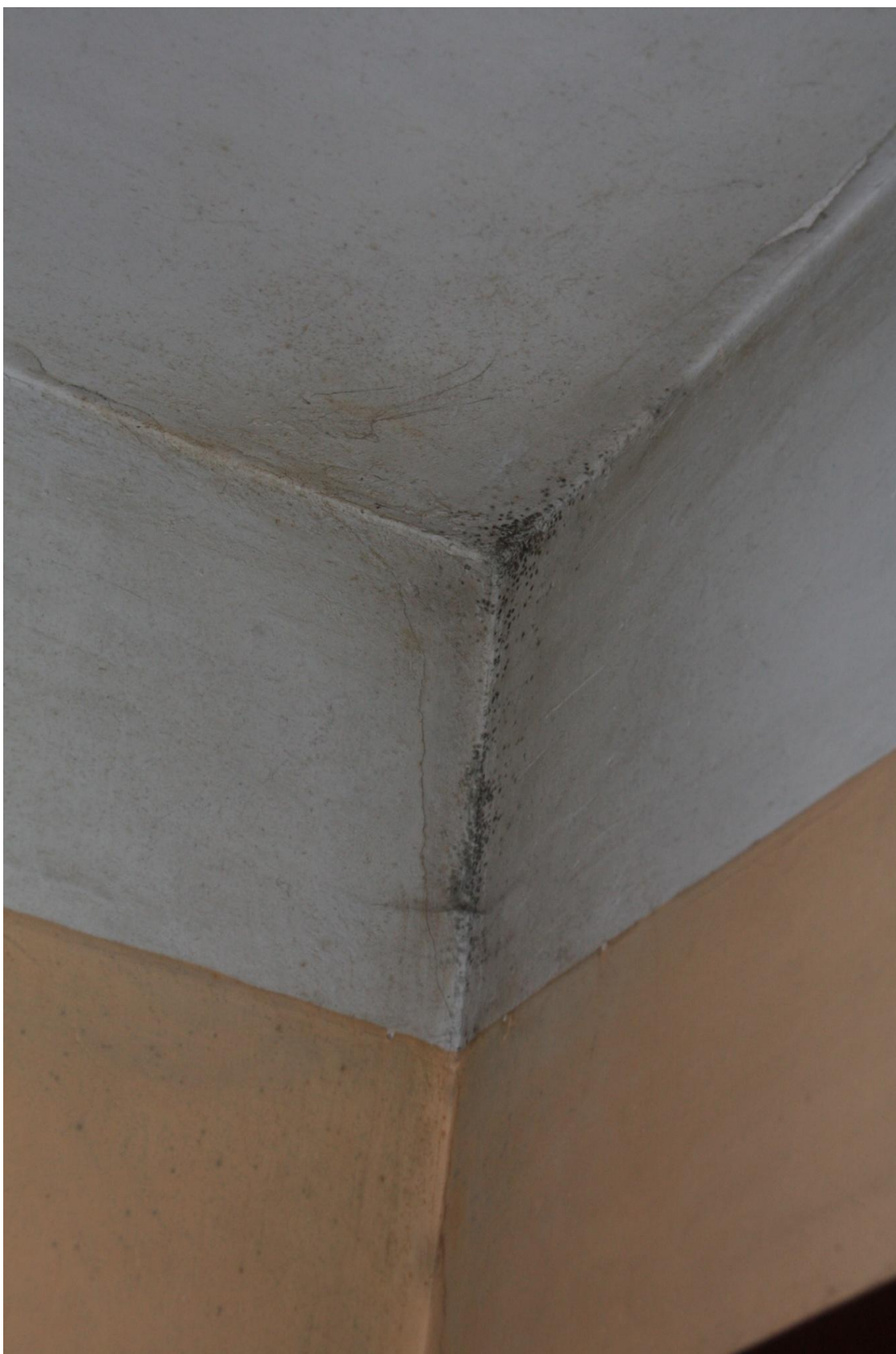
Foto L1. 7. Soojustuse puudulikkusest tingitud hallitus endise teenindusruumi nurgas
