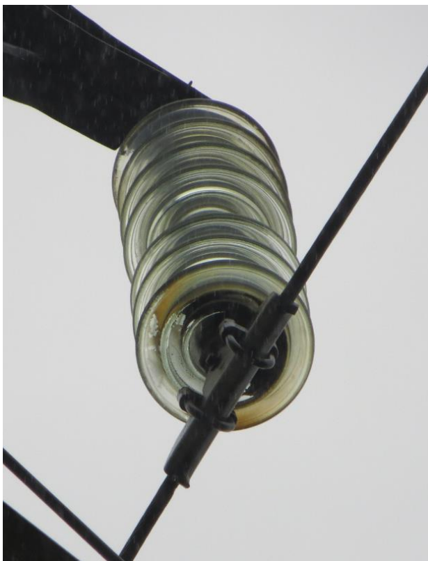
Joonis L.9. Saastunud klaasisolaatorkett
