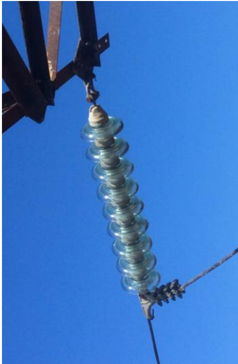
Joonis L.8. Puhas klaasisolaatorkett
