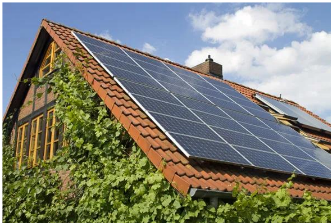
Joonis 1.1. Fotoelektrilised päikesepaneelid katusel [6]
