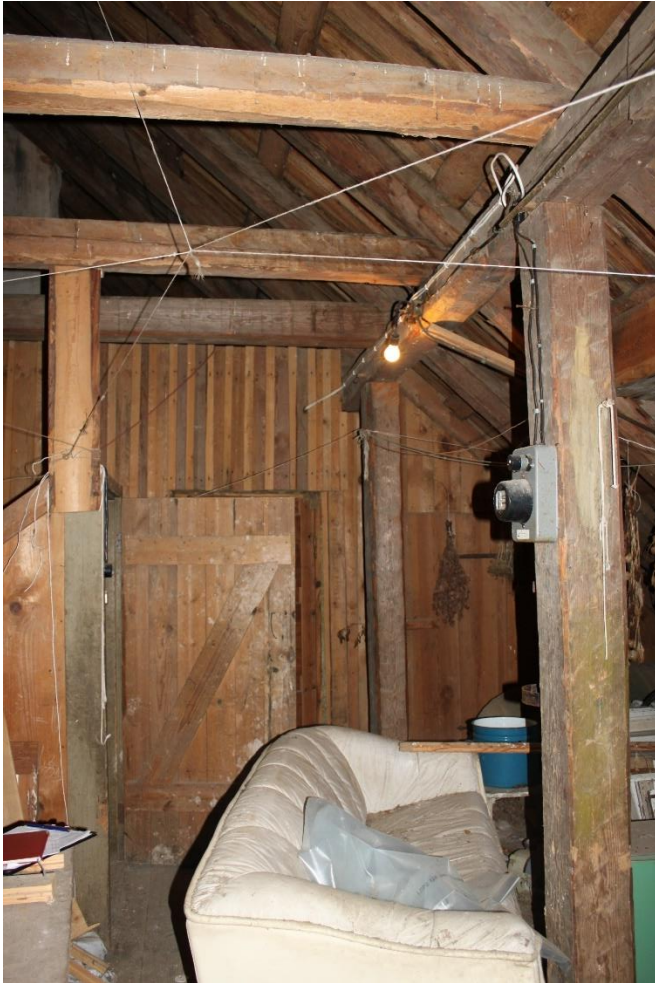
Foto 5. Originaalne katusekonstruktsioon. Detsember 2020. Autor: Elo Sinisaar
