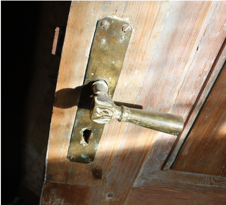
Foto 3.17. Säilinud vasest ukse link uksele U17. Aprill 2021. Autor: Elo Sinisaar
