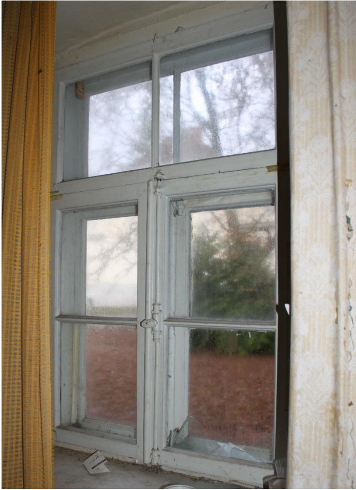
Foto 3.15. Originaalne hästisäilinud puitaken A6. Aprill 2021. Autor: Elo Sinisaar
