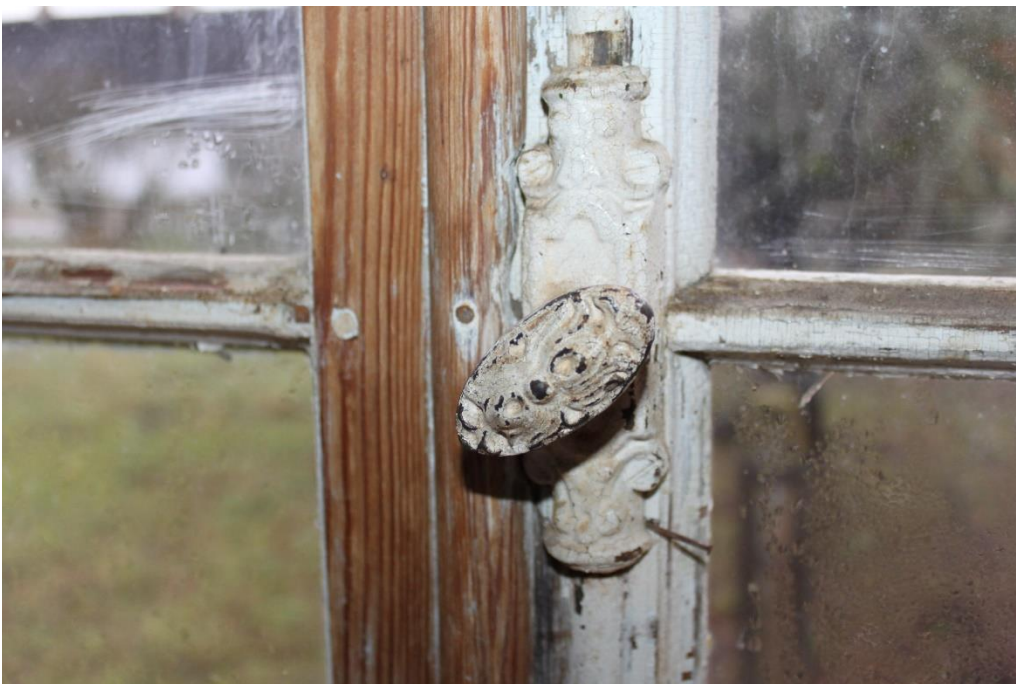
Foto 3.14. Säilinud originaalne kremoon A10 aknal. Aprill 2021. Autor: Elo Sinisaar
