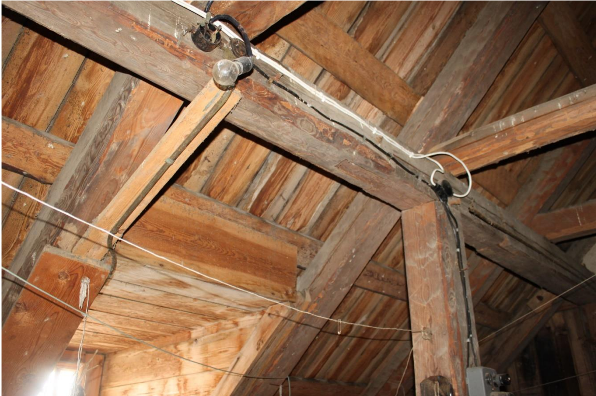
Foto 3.21. Katuse kandekonstruktsioon – toolvärk pennide ja sarikatega. Aprill 2021. Autor: Elo Sinisaar
