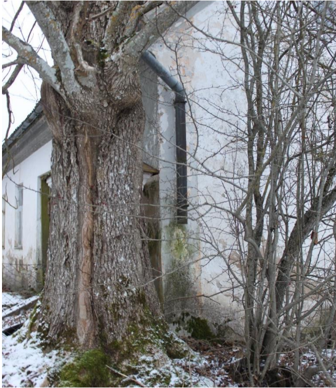
Foto 3.7. Loodenurgas kasvav puu ja võsa eemaldada. Amortiseerunud sadeveesüsteem korrastada. November 2020. Autor: Elo Sinisaar
