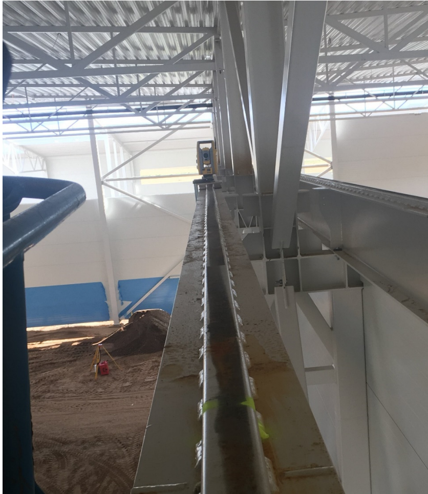
Joonis 5.5 Rakisele kinnitatud elektrontahhümeeter talal
