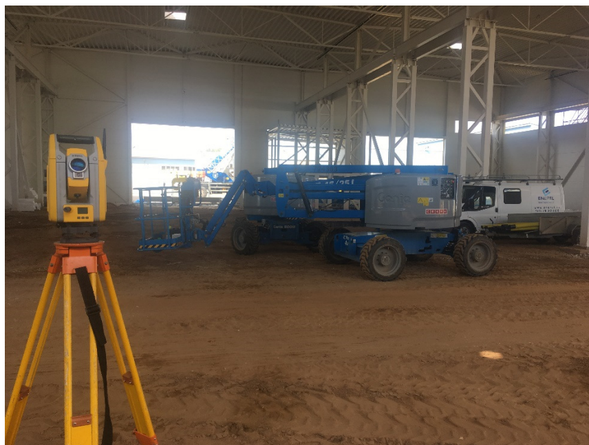
Joonis 4.4 Elektrontahhümeeter Trimble S5 ja korvtõstuk Genie Z 45/25 RT J tagaplaanil. Fotol on näha ka uurimise all olevat kraanateed ja hoone ehitusjärku
