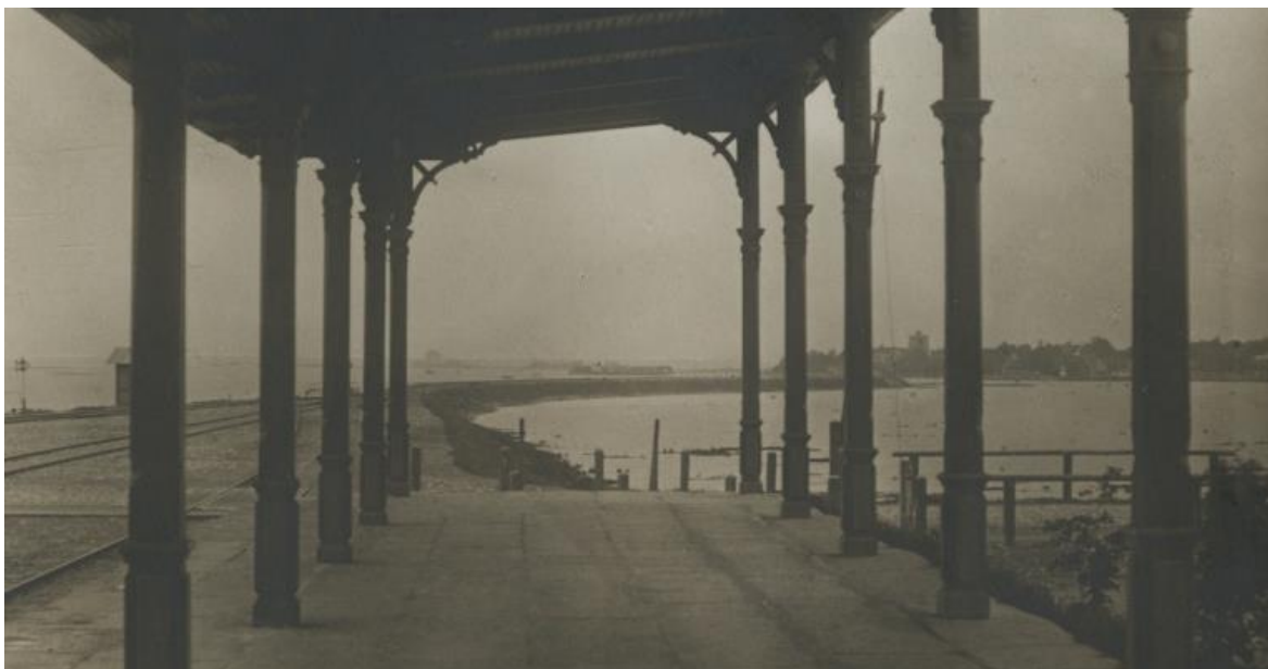
Joonis 4.7 Vaade raudteetammile Haapsalu jaama perroonilt (20. saj. algus).
