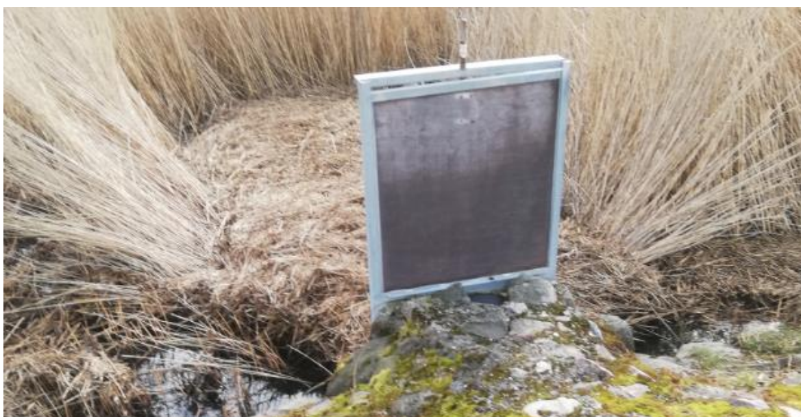
Joonis 4.3 Hetkel roostikku merest eraldav rikkis (avatud asendis) siibrisüsteem, taamal on näha roomass, mis suudme juurde kuhjunud on (Autori foto: 9.03.2020)
