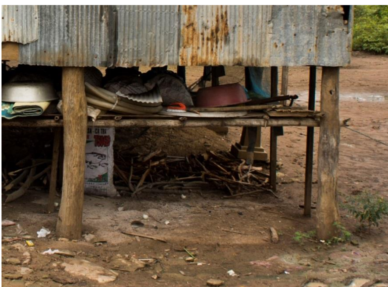
Joonis 4.5. Puidust postvundament Kbal Speani.
