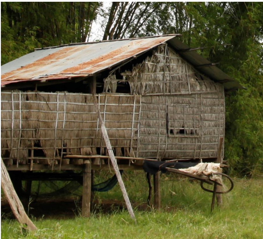
Joonis 4.31. Parandamata ning toestatud sein Chorng Kouki külas.
