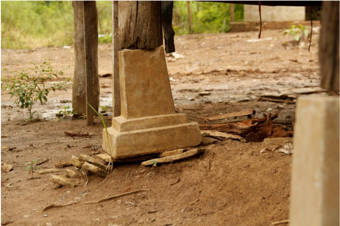
Joonis 4.29. Maapinnale asetatud tugiposti kahjustus Kbal Speani külas.
