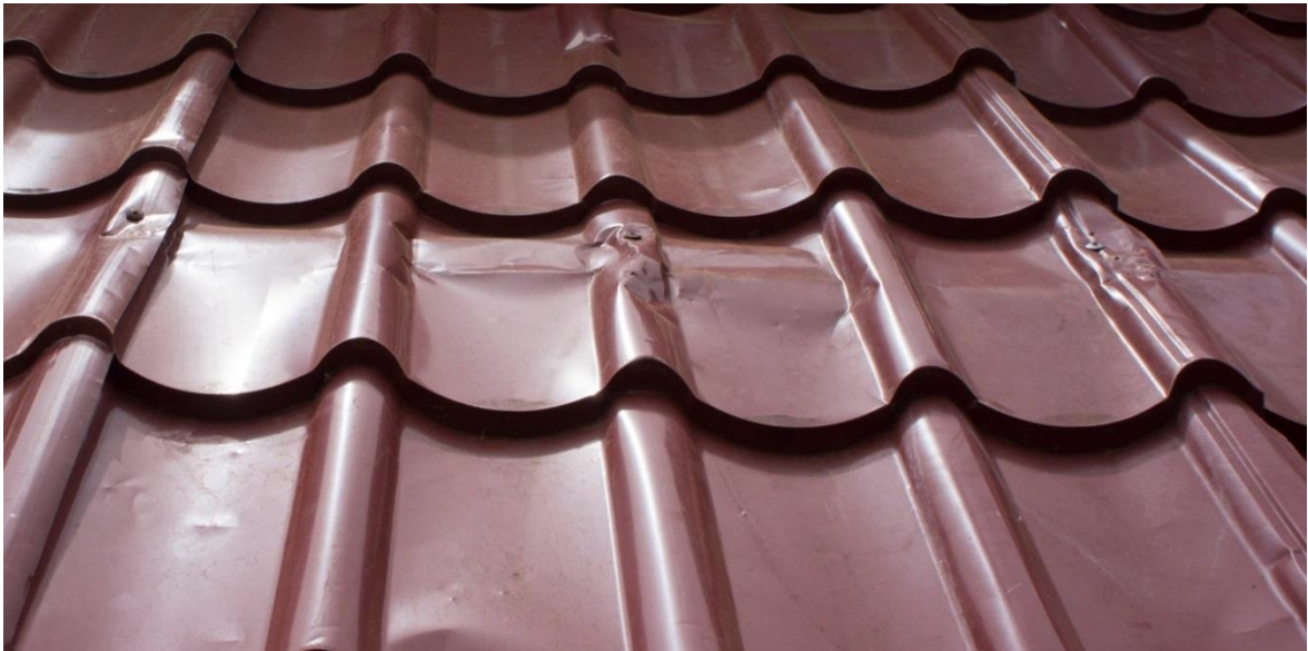
Joonis 4.30. Ebaefektiivsete katusekinnitite kasutamine ning katusematerjali kahjustus Kbal Speani külas.
