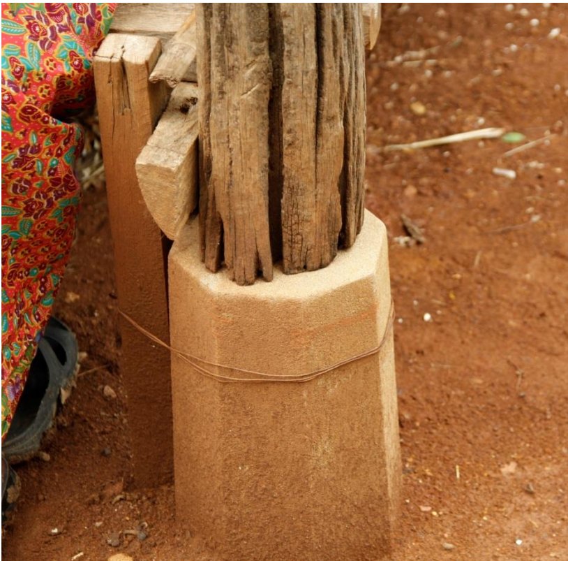
Joonis 4.28. Puitposti ja betooni ühendus Kbal Speani külas.
