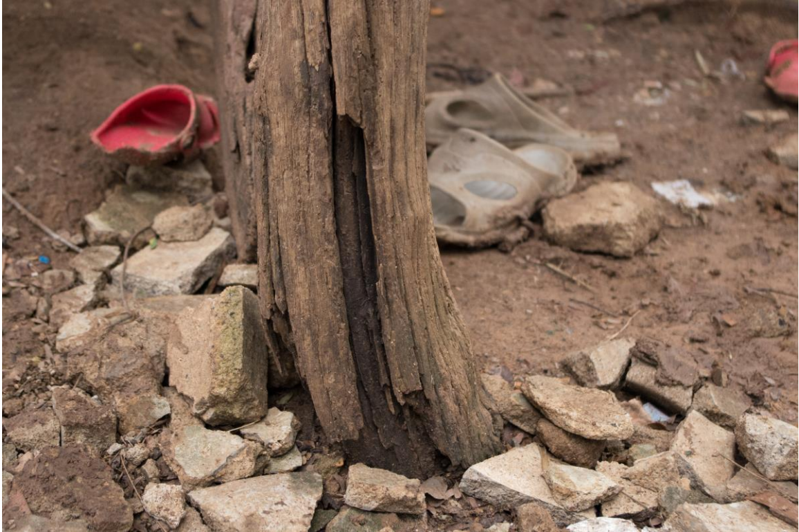
Joonis 4.27. Niiskuskahjustusega tugipost Kbal Speani külas.
