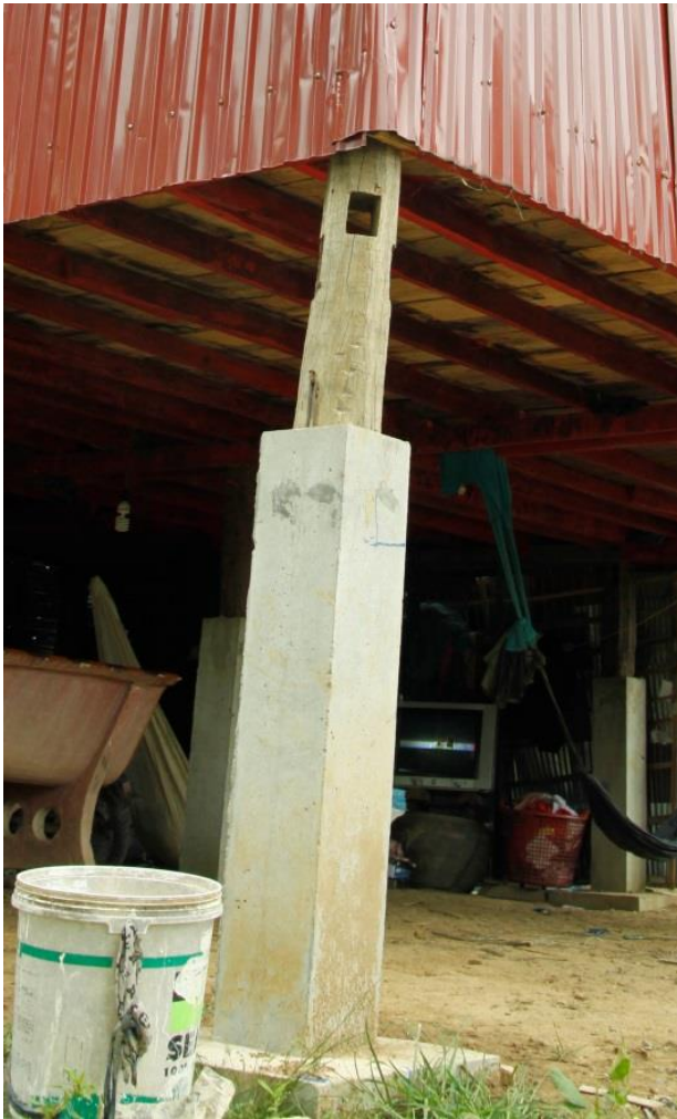
Joonis 4.11. Maapinnale asetatud monteeritud betoonist taldmikuga postvundament Chornng Kouki külas.
