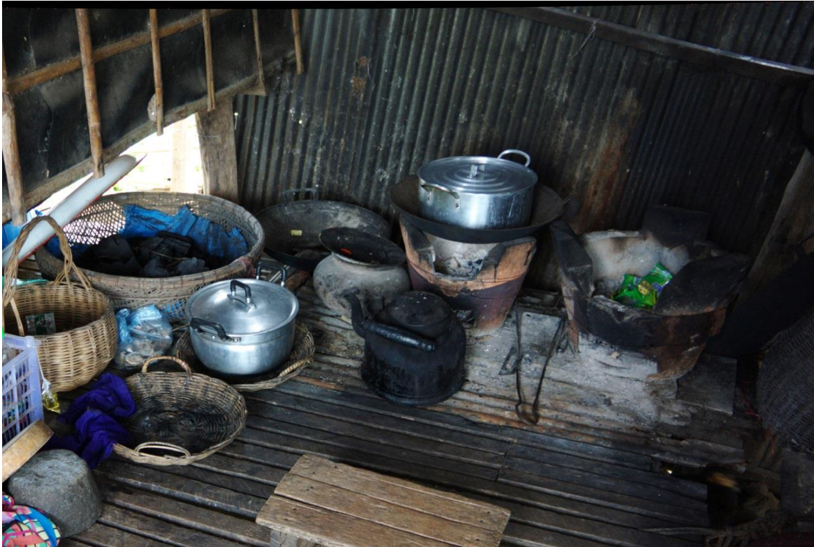
Joonis 4.34. Puitdetailidele avatud tulekolle ning puidu kahjustused Kbal Speani külas.
