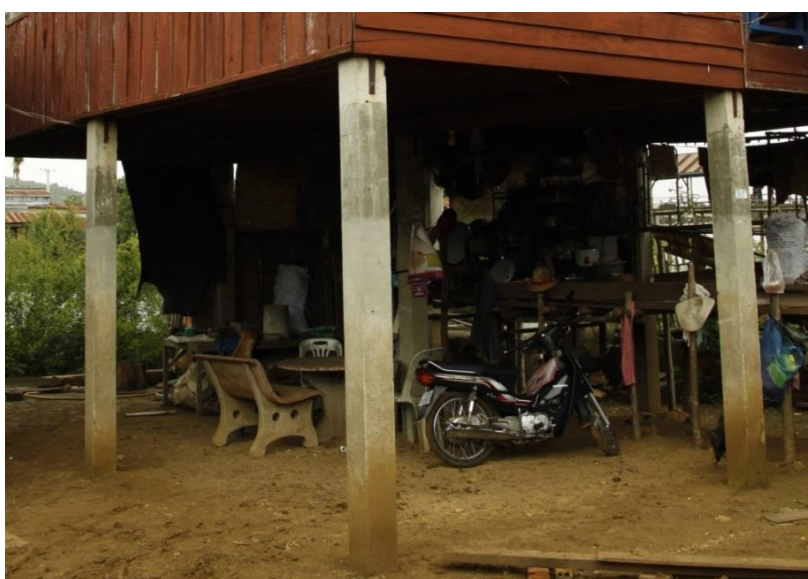
Joonis 4.7. Monteeritud betoonist taldmikuga postvundament Prey Rosey külas.
