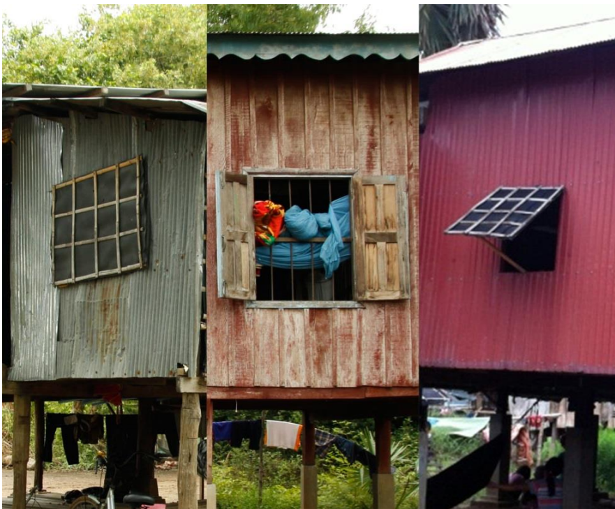
Joonis 4.24. Avatäidete näited Banteay Meanchey provintsi külades.
