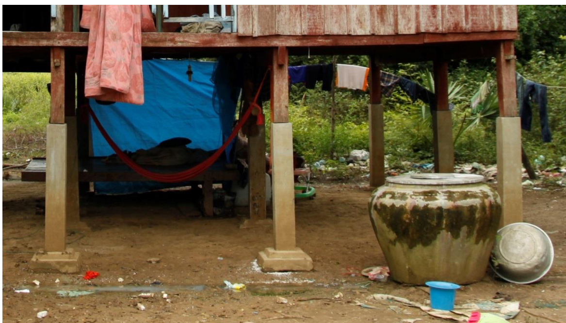
Joonis 4.10. Maapinnale toetatud monteeritud betoonist taldmikuga postvundament Kbal Speani külas.
