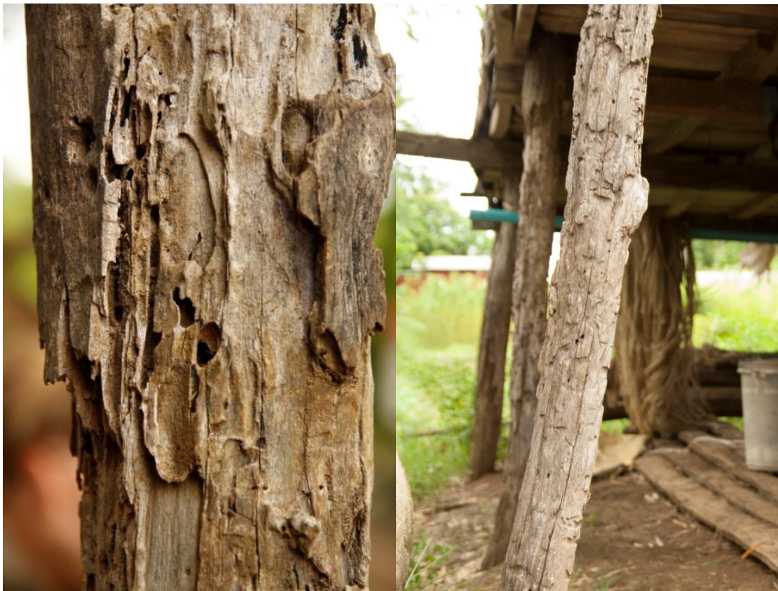
Joonis 4.26. Kahjurite kahjustatud tugipostid Kbal Speani külas.
