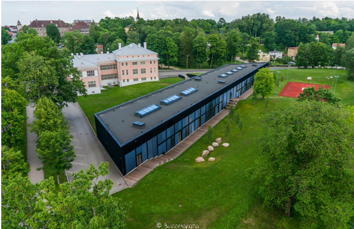
Esiplaanil Viljandi riigigümnaasium koos tagaplaanil paikneva endise Valuoja põhikoolihoonega. (Allikas: Droonipiloodid, 2016)
