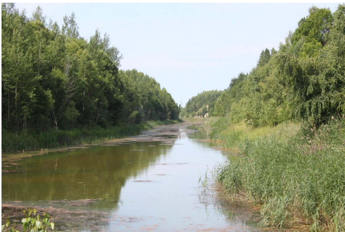
Joonis 29 Põhjakarjääri tranšee, mõõtmispunkt nr. 9
