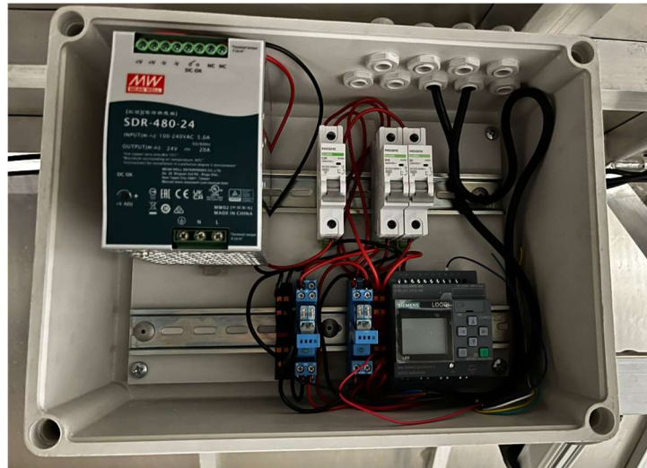
Joonis 4.11. Ühe mootoriga külje kontrollimiseks komplekteeritud kilp
