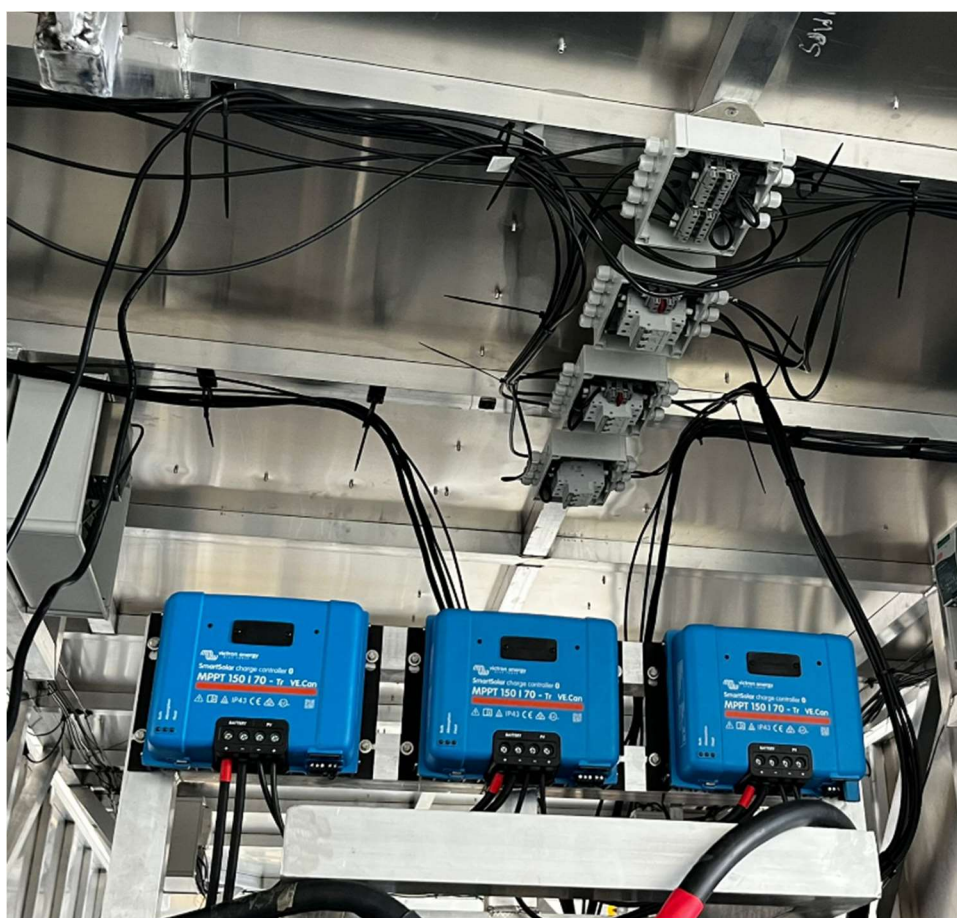
Joonis 4.7. Harukarpide paigaldus
