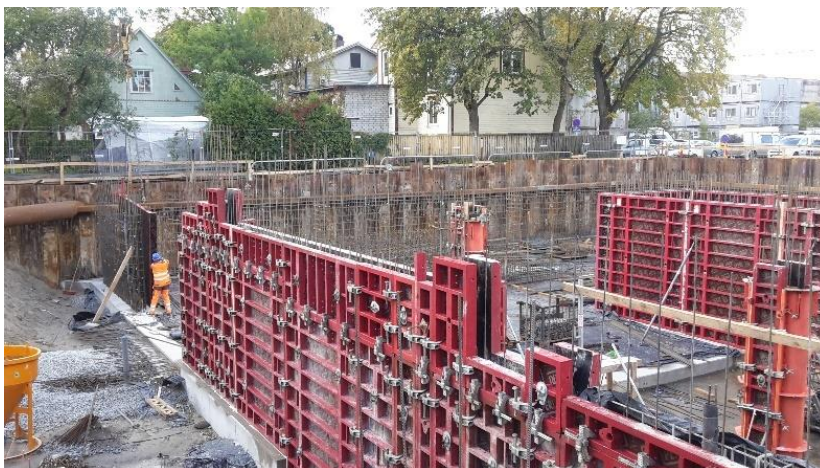
Joonis 4. 0 - korruse seinte rakestamine kasutades moodulkilpe
