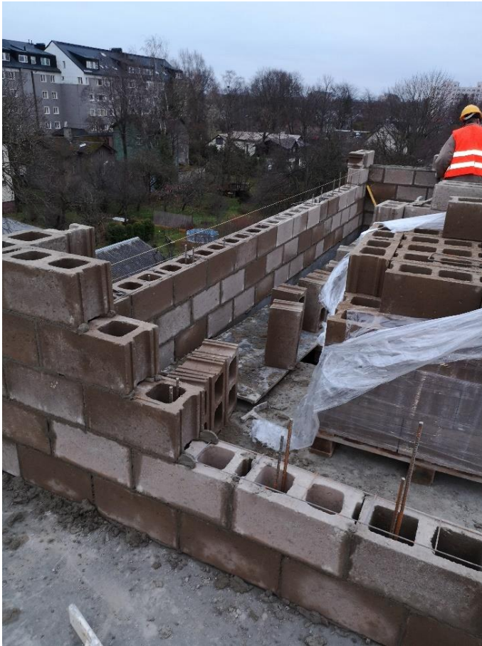
Joonis 7. Müürikivist seinte ladumine
