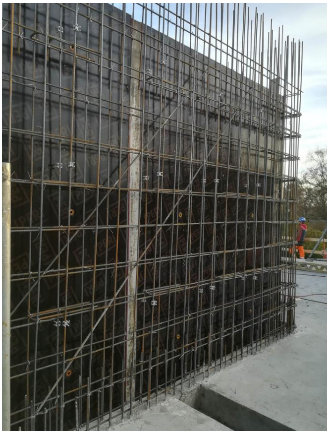
Joonis 5. 2.korruse trepikoja monoliitsete seinte armeerimine
