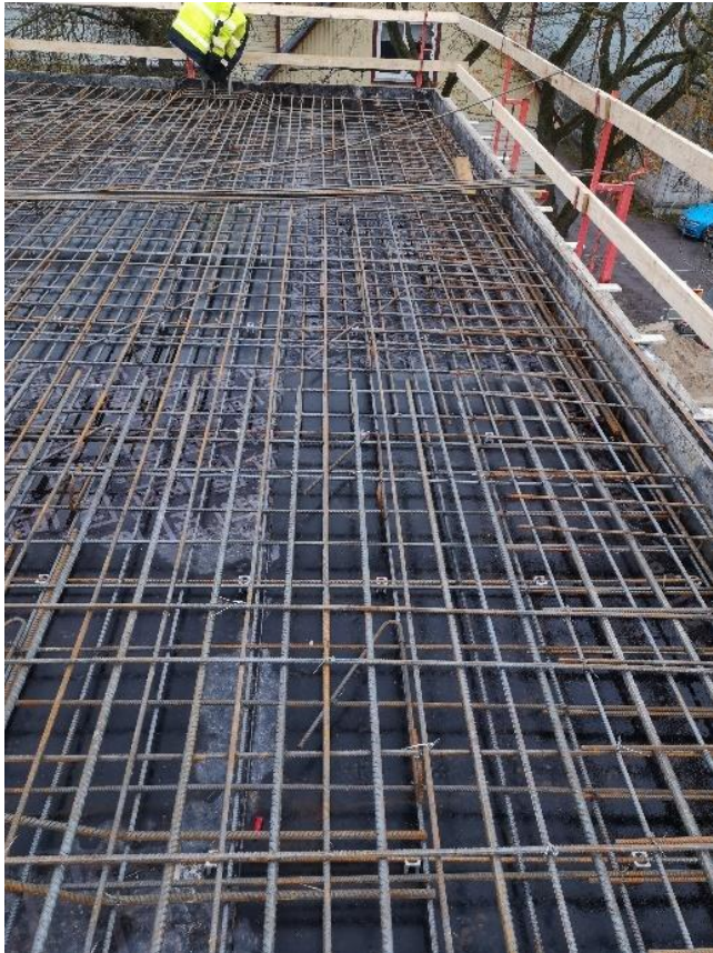
Joonis 8. Vahelagede armeerimine
