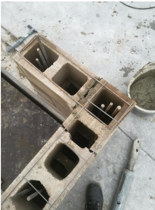
Joonis 6. Trepikodade õõnesplokkmüüritise armeerimine
