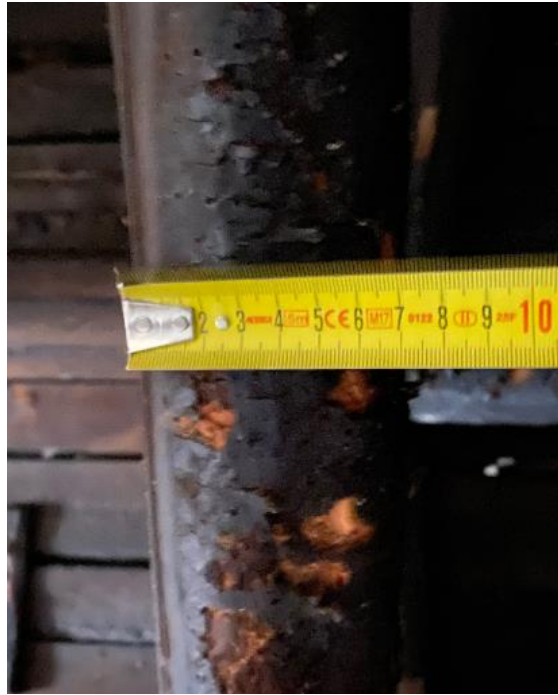
Joonis 2.27 Penni läbimõõt (autori foto, aprill 2020)
