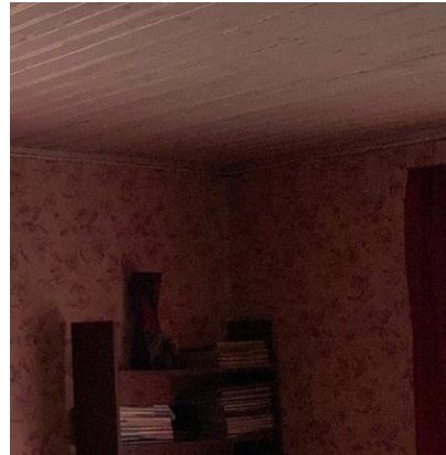
Joonis 2.48 Termofotoga 3 samast kohast tehtud foto (autori foto, aprill 2020)
