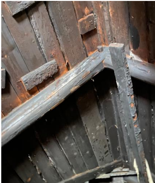
Joonis 2.28 Tapp-punlliitega sarikate kinnitus (autori foto, aprill 2020)
