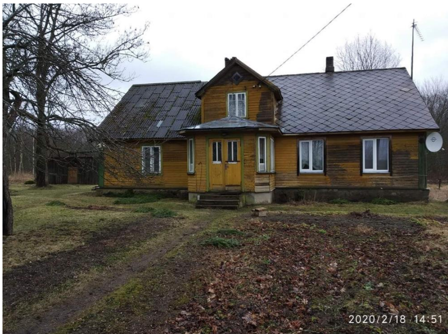
Joonis 2.3 Väike-Saare talu eluhoone edela fassaad (autori foto, veebruar 2020)
