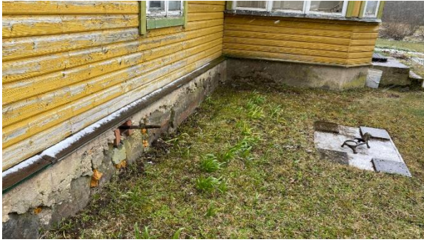
Joonis 2.9 Hoone edelapoolse fassaadi veevõtukoht (autori foto, aprill 2020)
