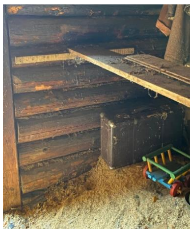
Joonis 2.15 Hoone nurkades asuvad vertikaalsed lauad (autori foto, aprill 2020)
