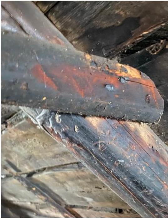
Joonis 2.26 Penni ja sarika kinnitus naeltega (autori foto, aprill 2020)
