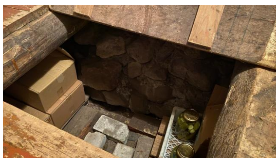
Joonis 2.7 Väikesema köögi kelder (autori foto, aprill 2020)
