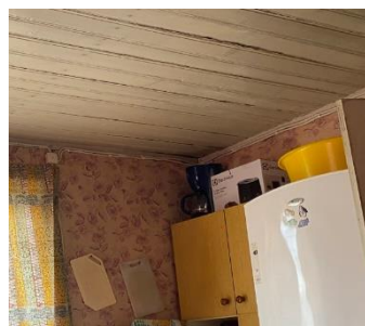
Joonis 2.47 Termofotoga 2 samast kohast tehtud foto (autori foto, aprill 2020)
