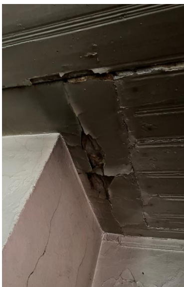
Joonis 2.24 Kahjustunud lagi (autori foto, veebruar 2020)
