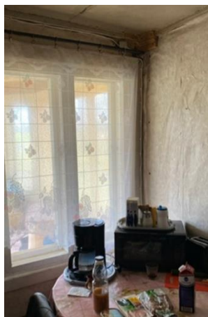
Joonis 2.46 Termofotoga 1 samast kohast tehtud foto (autori foto, aprill 2020)
