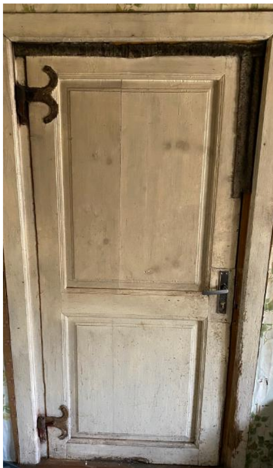
Joonis 2.40 Hoone algupärane uks suurest köögist tuulekotta (autori foto, aprill 2020)
