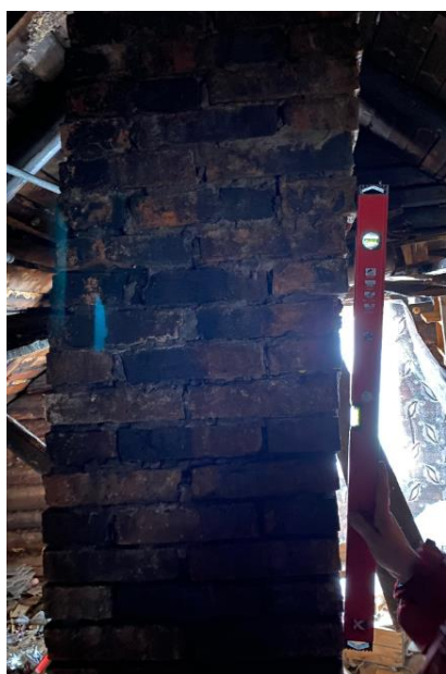
Joonis 2.41 Viltu laotud korsten (autori foto, aprill 2020)
