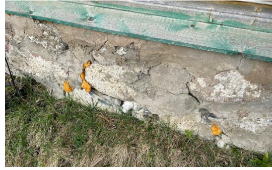
Joonis 2.10 Maakividest sokkel (autori foto, aprill 2020)
