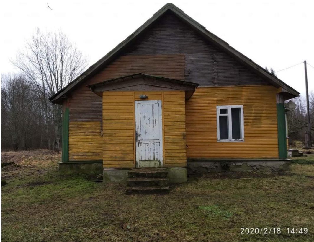
Joonis 2.5 Väike-Saare talu eluhoone loode fassaad (autori foto, veebruar 2020)
