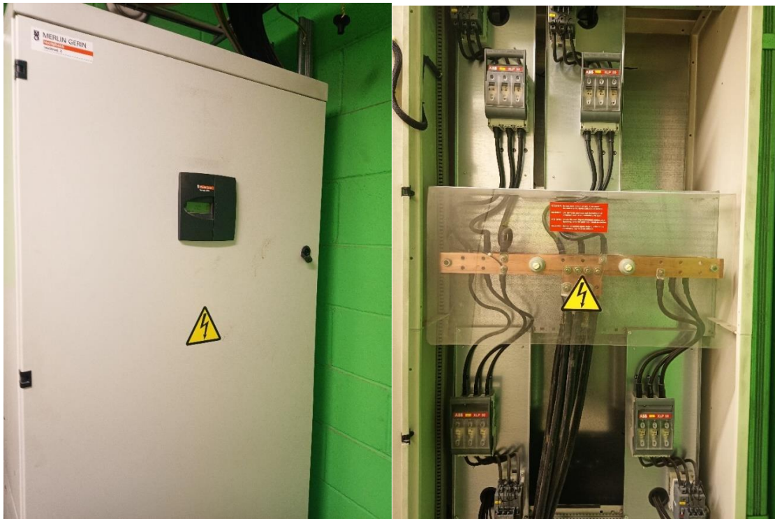
Joonis 24. Reaktiivvõimsus kompenseerimiseks kondensaatorseadmed
