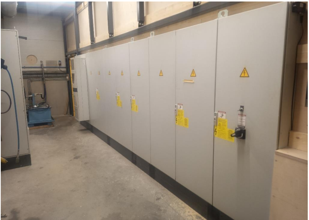
Joonis 4. Hõõvel H3500 üks kolmest elektrikilbist.
