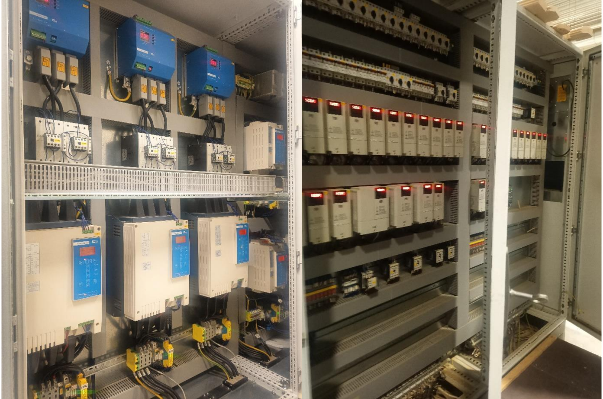
Joonis 5. Hõövel H3500 (vasakul) ja otsatapiliini Sacot (paremal) sagedusmuundurid.
