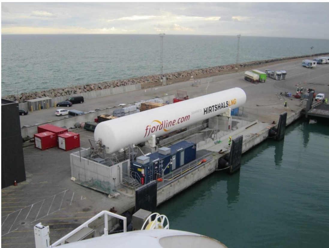
Pilt 2.2. LNG punkerdamise terminal Taanis Hirtshalsis. Fjörddline laevade teenindamiseks. [Fjörddline]
