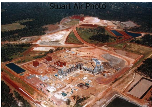
Pilt 2.11 Üks viimase aja suuremaid põlevkivi katseteadmeid – AOSTRA Taciuk Processor (ATP) tehnoloogia katsetamine Austraalias
