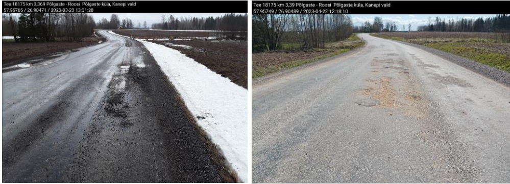
Joonis 3.20 Km 3,369 katte lagunemine seisuga 23.03.2023 (vasakul) ja joonis 3.21 km 3,39 katte lagunemine seisuga 22.04.2023 (paremal) (Autori erakogu)
