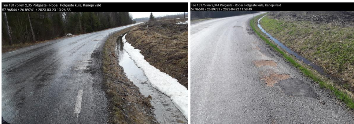
Joonis 3.35 Km 2,35 paremas servas defekt 23.03.2023 seisuga (vasakul) ja joonis 3.36 sama asukoht seisuga 22.04.2023 (Autori erakogu)
