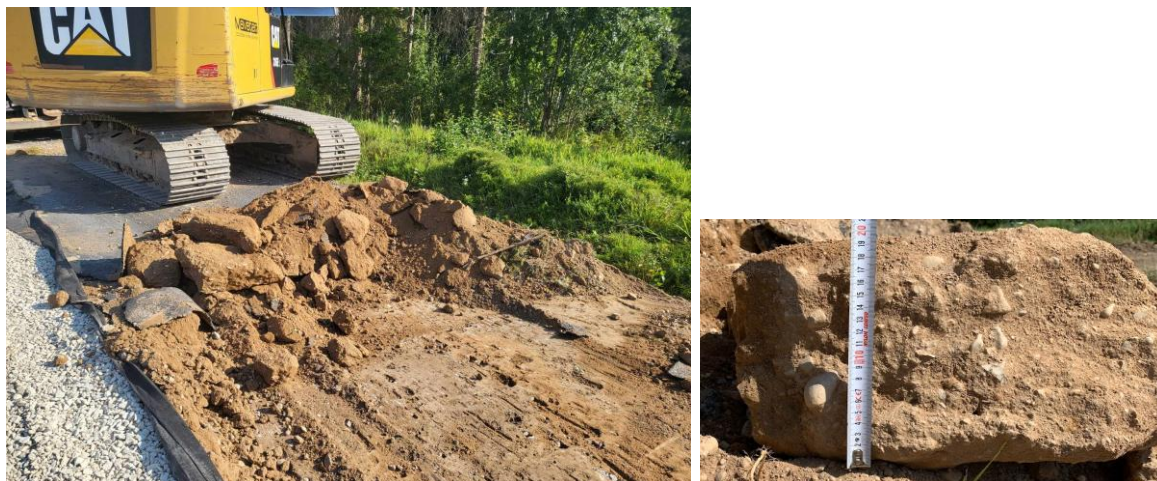
Joonis 3.39 Vasaku sõiduraja väljakaevamine (vasakul) ja Joonis 3.40 stabiliseeritud tüki suurus ca 20 cm (paremal) (Autori erakogu)
