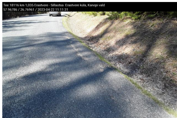
Joonis 3.15 Servas lagunemine km 1,057 (vasakul) joonis 3.16 Serva lagunemine km 1,035 (paremal) (Autori erakogu)
