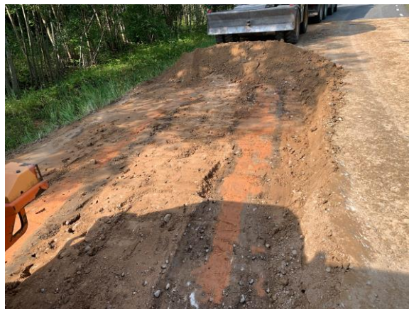
Joonis 3.68 Ehituse käigus tekkinud roobas (Autori erakogu)
