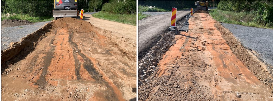
Joonis 3.69 Roopad parema suuna sõidurajal (vasakul) ning joonis 3.70 roobas teljel (paremal) (Autori erakogu)
