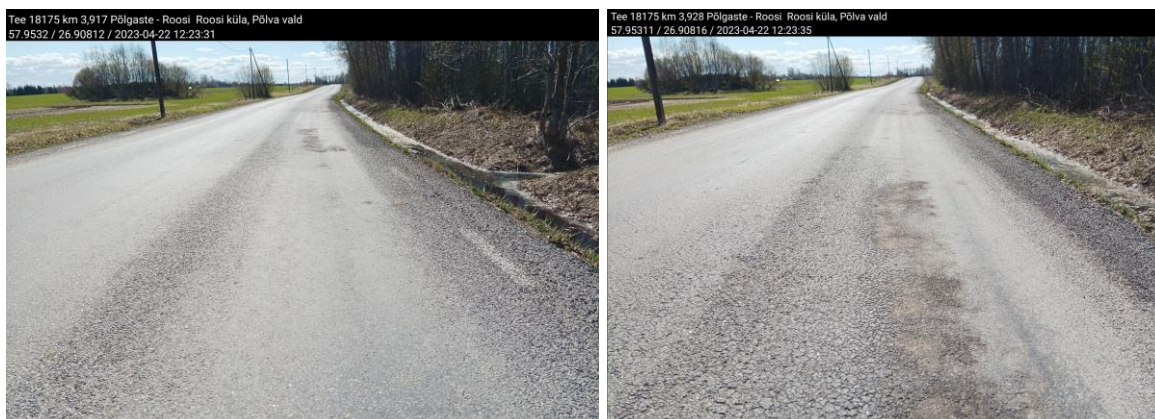
Joonis 3.41 Paremal sõidurajal esinevad võrkpraod km 3,917 (vasakul) ja Joonis 3.42 km 3,928 (paremal) (Autori erakogu)
