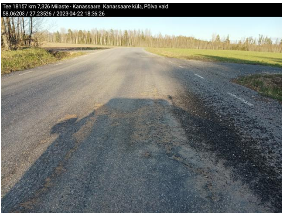
Joonis 3.66 Km 7,32 defektne koht paremas sõidurajas (vasakul) ja joonis 3.67 defektse koha väljakaeve (paremal) (Autori erakogu)
