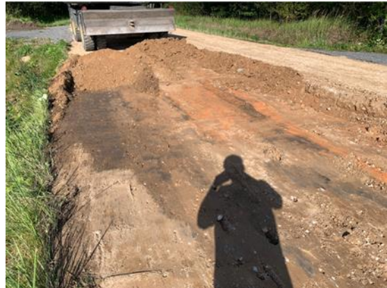
Joonis 3.64 Km 7,33 defektne koht paremas sõidurajas (vasakul) ja joonis 3.65 väljakaeve defektsest kohast, teise nurga all (Autori erakogu)
