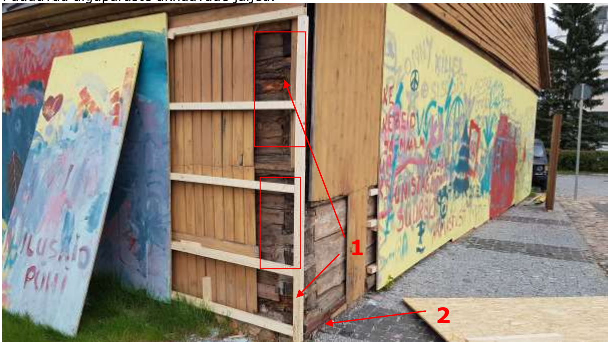
Foto 3.12 – Hoone edelapoolne avatud nurk. (19.05.2020) 1 – Nurgatappides esineb mitmeid kahjustusi. Vajalik kahjustuste eemaldamine ja proteesimine algupärase eeskujul. 2 - Sokkel on põhimõtteliselt selles nurgas olematu.
