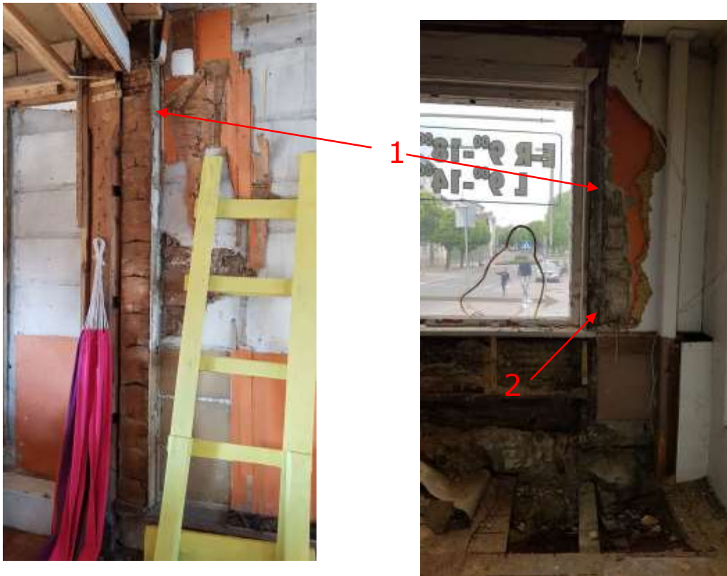
Foto 3.52 – (26.05.20 ja 08.08.20) 1 – metallankrutega fikseeritud otsatapid. 2 – tegemist on algupärase hoone nurgatapiga.
