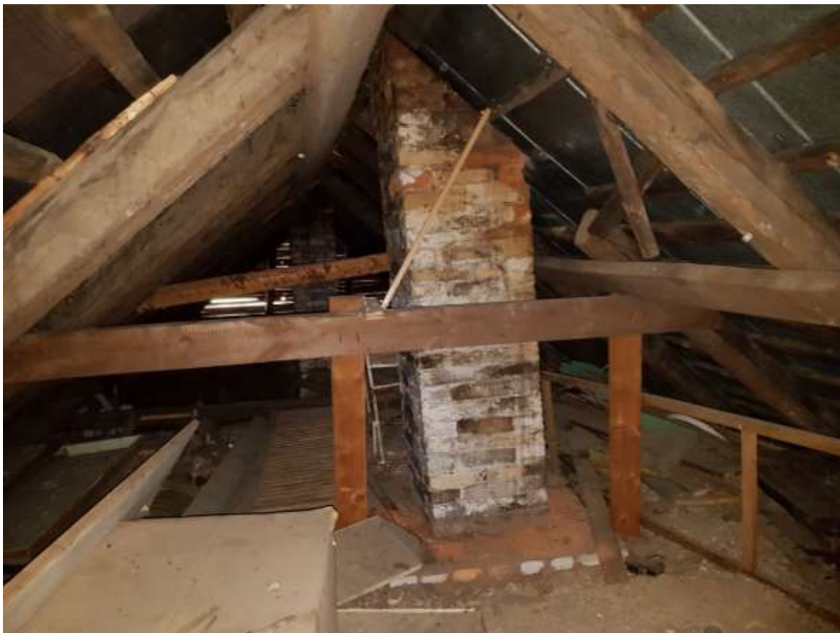
Foto 3.60 – (21.04.20) hilisema korstna ümber ehitatud sarika toestussüsteem.
