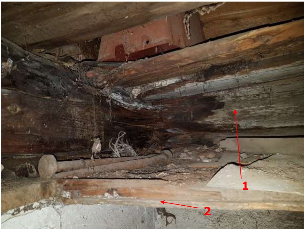
Foto 3.65 – (06.08.20) trepikojast nähtav vahelae läbilõige. 1 – laelauana kasutatud värvitud poola laudis. 2 – olemasolev laelaudis.
