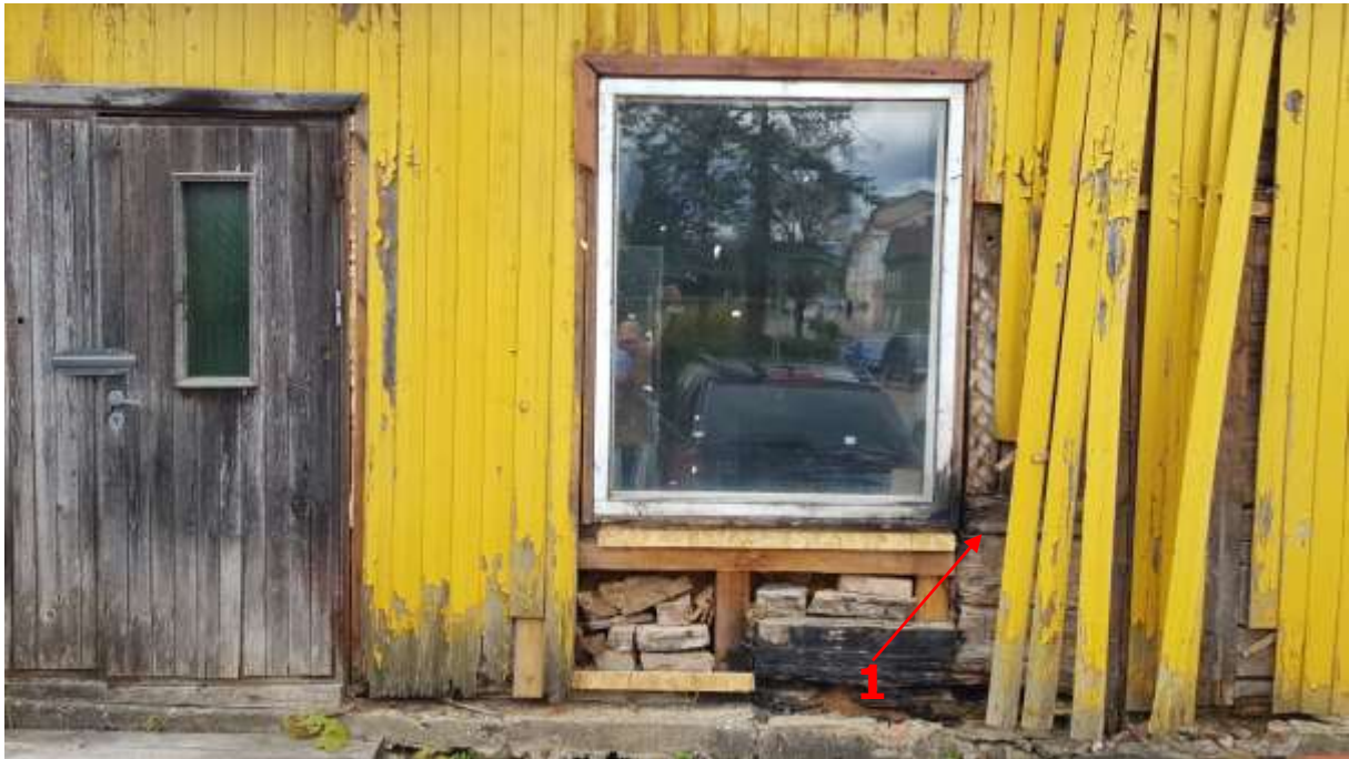
Foto 3.11 – (19.05.2020) 1 - puitkarkass konstruktsioon lõppeb vahetult pärast aknaava A-2. Rõht ja püstpalgid paremal pool pole omavahel keeltapiga seotud. Puuduvad algupäraste aknaavade jäljed.
