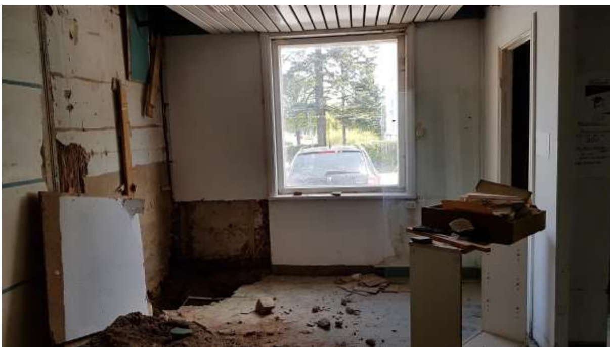
Foto 3.31 - (26.05.20) vaade ida välisseinale
