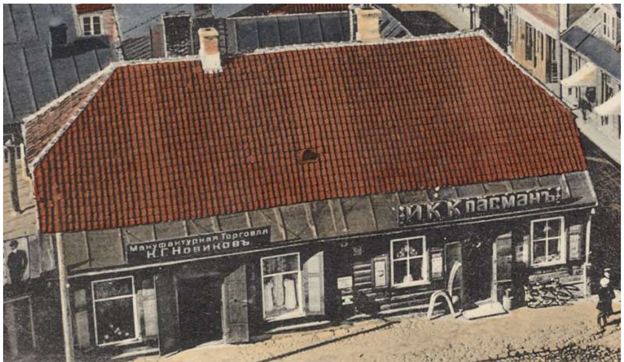
Foto 2.6 – suurendus fotost 2.5. Vaade kirikutornist Kesk tn 19 hoonele 20.sajandi alguses (1910-1912). Katuse ümberehitust pole veel toimunud. Nähtaval akna- ja ukseuugid, poolkelpadega kivitatus ning katuseuuk. Vasakpoolsed aknad sarnanevad leitud olemasolevate akendega hoone Riia tänavapoolsel küljel. Fassaadi katab lai horisontaalne laudis. Hoones tegutsevad J.K.Klasman ja K.G.Novikov.
