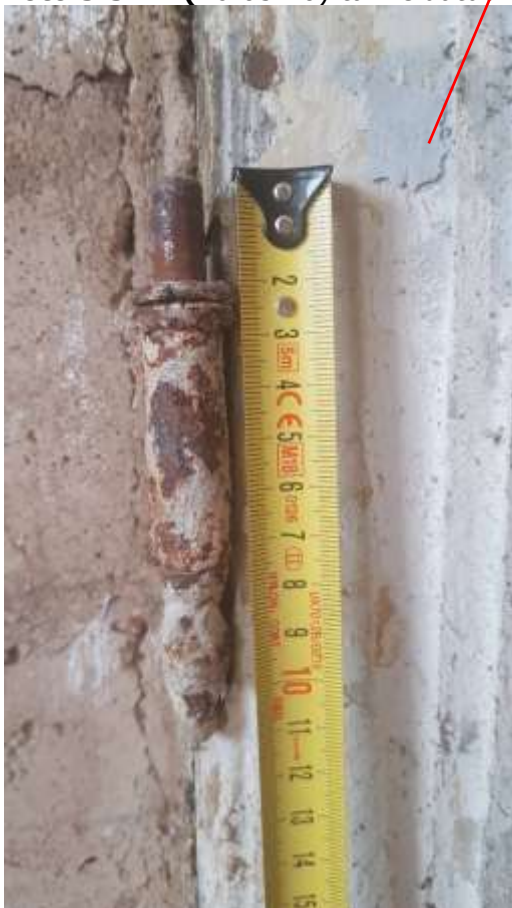
Foto 3.37 – (26.05.20) tahveldatud tiibukse negatiiv ja selle säilinud uksehinged
