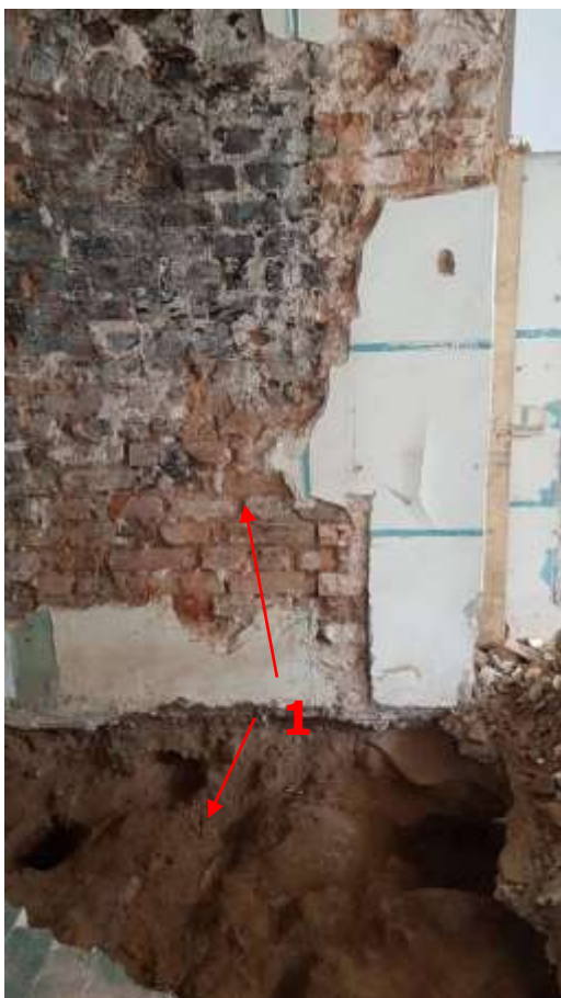
Foto 3.35 - (26.05.20) 1 - lammutatud küttekolde jälg ning selle munakivi vundament.
