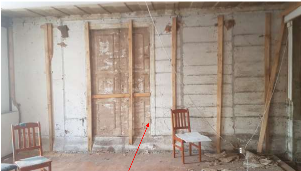
Foto 3.37 – (26.05.20) tahveldatud tiibukse negatiiv ja selle säilinud uksehinged
