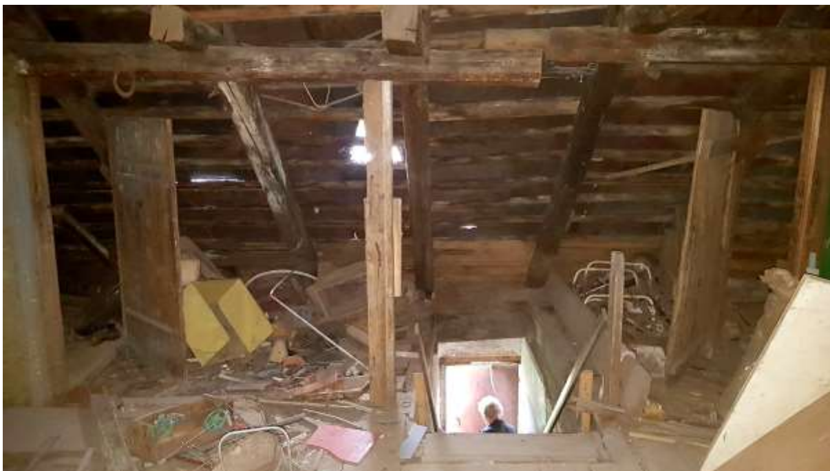
Foto 3.56 – (06.08.20) eemaldatud toolvärk süsteem ja paigast nihkunud osad katusel.
