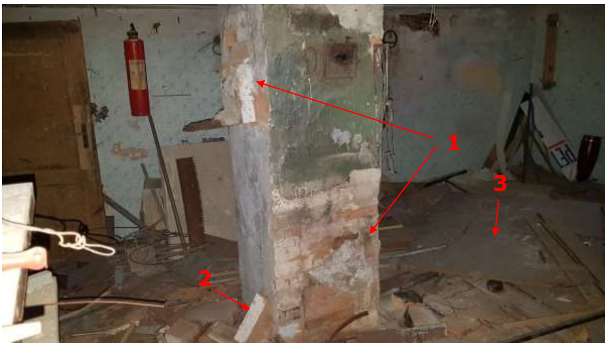
Foto 3.61 – (04.21.20) ruum 12. 1 - väljalõhutud pliit/ahi. 2 - lõhutud ahju kahhelkivi. 3 - koormust tekitav kultuurikiht.
