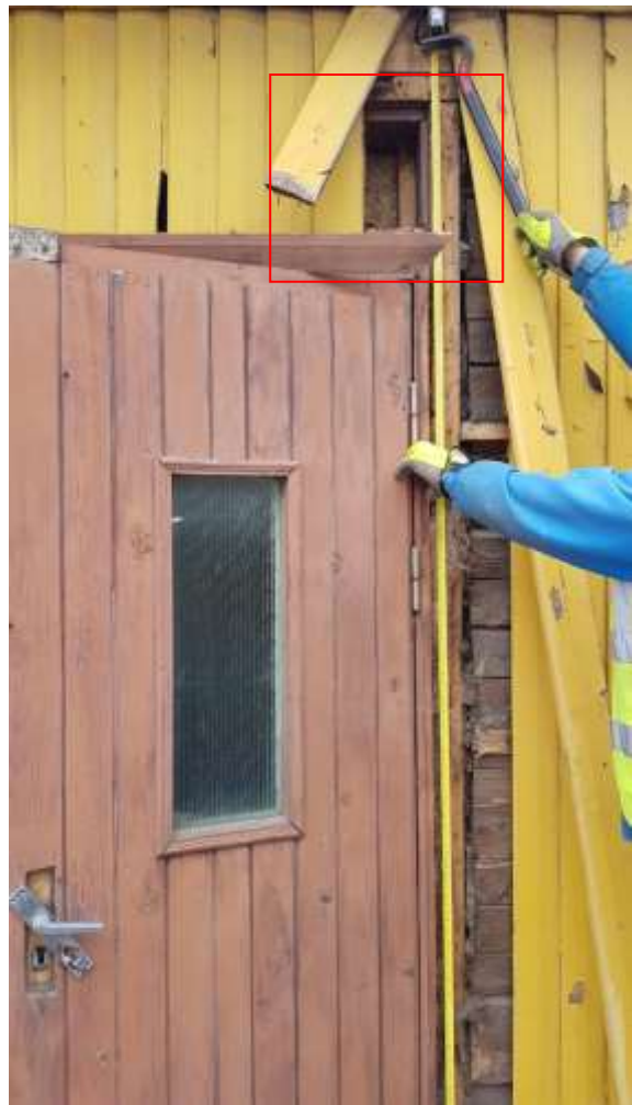
Foto 3.24 – (19.05.20) paljastus algupärane akna tenderpost.
