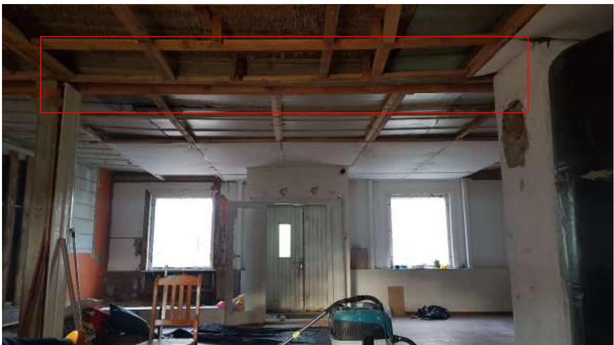
Foto 3.53 – (07.08.20) pikikandeseina eemaldamisest ning mittepiisavast toetusest tingitud läbipaine.
