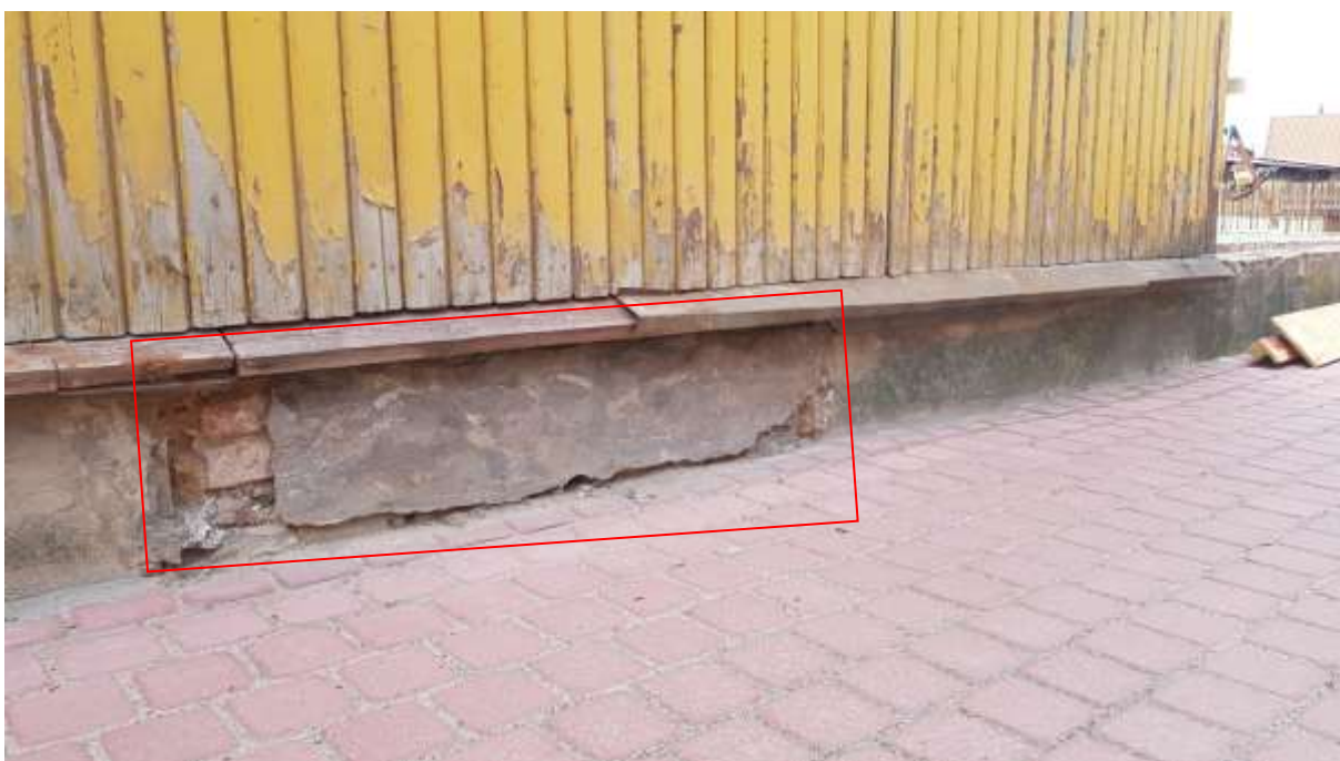
Foto 3.20 - (19.05.20) Riia tänavapoolsel küljel on olnud ukseava SA-8.
