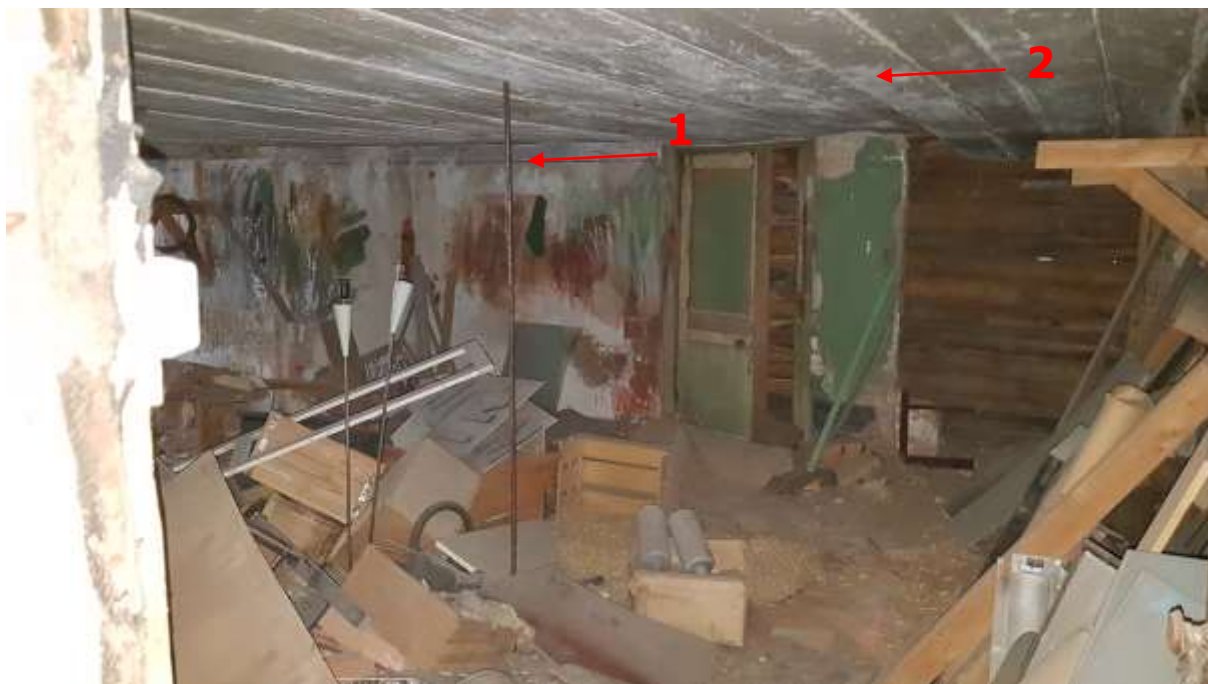
Foto 3.63 – ruum 11 (06.08.20) 1 - esimese korrusel abitala toetav ankur, mis kinnitub pennidele toetuva tala külge. 2 – sepisnaeltega laelaudis.
