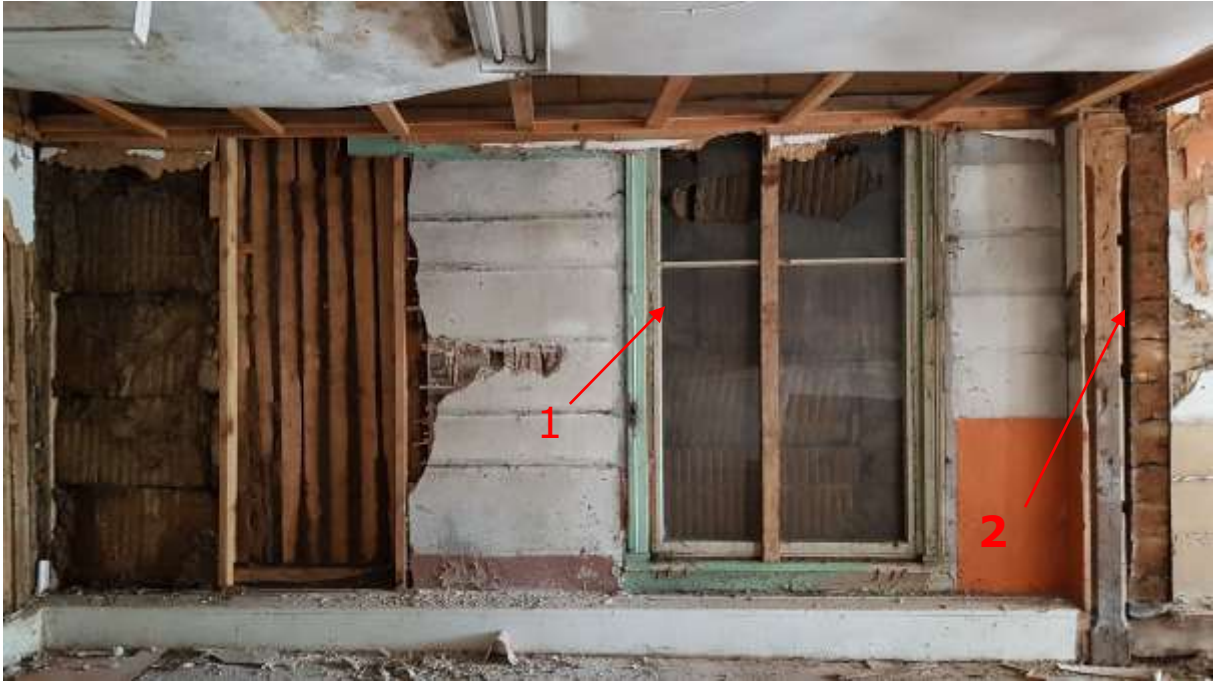
Foto 3.50 - (26.05.20) vaade põhjaseinale. 1 - kihtide alt avanesid 20.sajandi algusest pärinevad aknad. 2 – metallankrutega fikseeritud pikikandeseina otsatapid.
