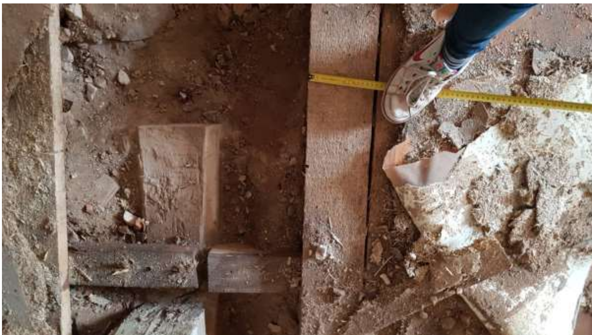
Foto 3.41 – (26.05.2020) põrand pinnasel hoone põhjapoolses osas. Š-7
