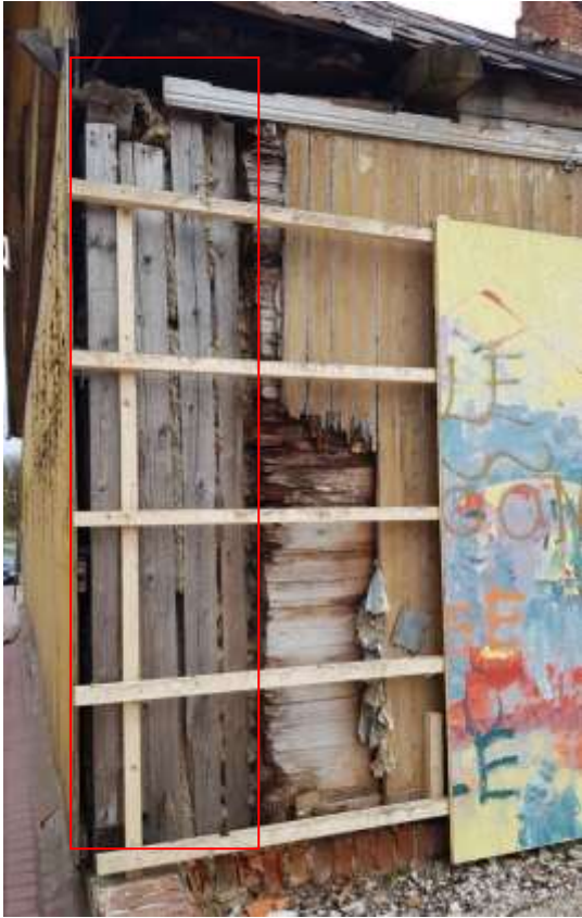
Foto 3.16 – (19.05.2020) Loode nurk ülesehitatud püstprusside ja puitkarkassiga
