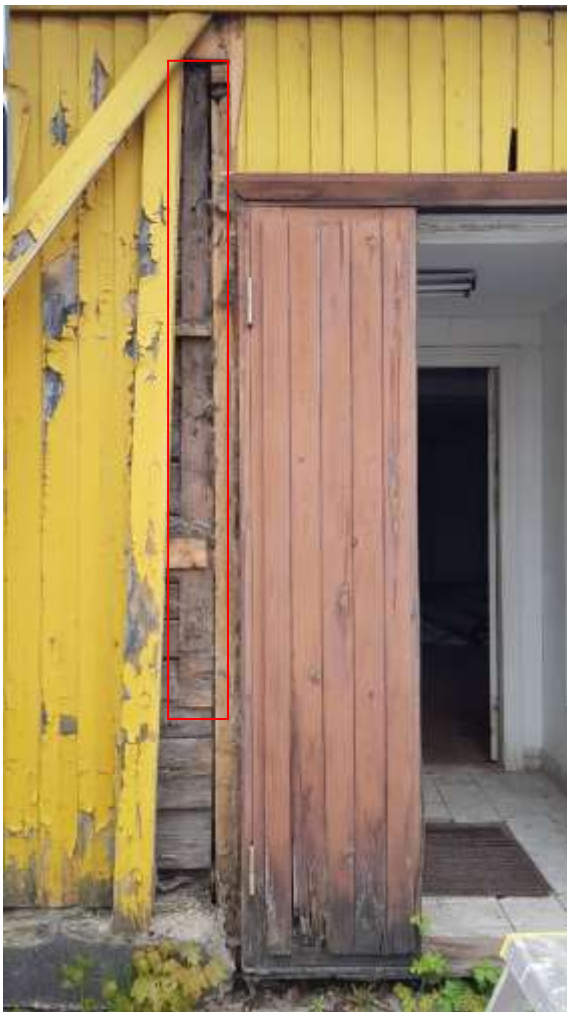
Foto 3.24 – (19.05.20) paljastus algupärane akna tenderpost.
