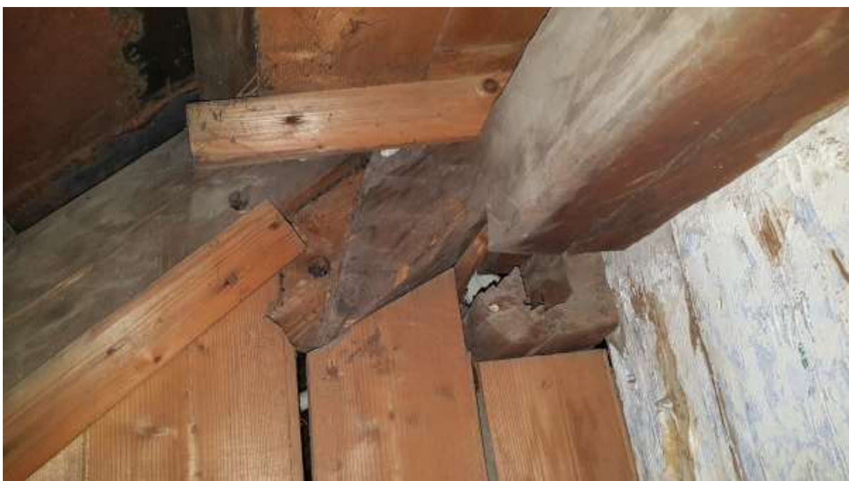
Foto 3.55 – (05.06.20) eemaldatud penni ots on paigast nihkunud
