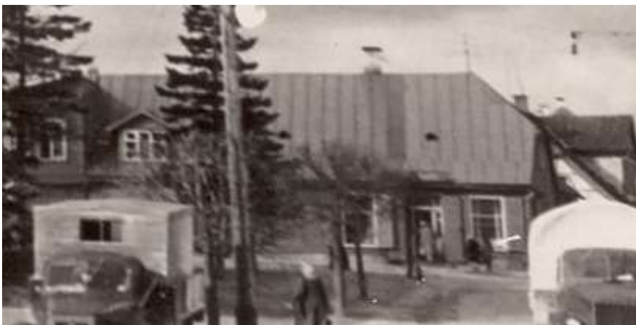
Foto 2.16 – suurendus fotost 2.15. Pildil on näha, et esifassaadi parempoolsed aknad on olnud vaheetapil suuremõõtmelised, sarnanedes olemasolevate Riia tn-poolsete akendega. Kivikatus vahetatud olemasoleva valtspleki vastu.
