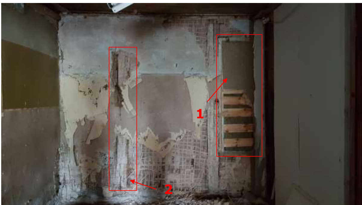
Foto 3.29 - (06.08.20) 1 - aknaava SA-6 ja 2 - algpärase ukse tenderpost.
