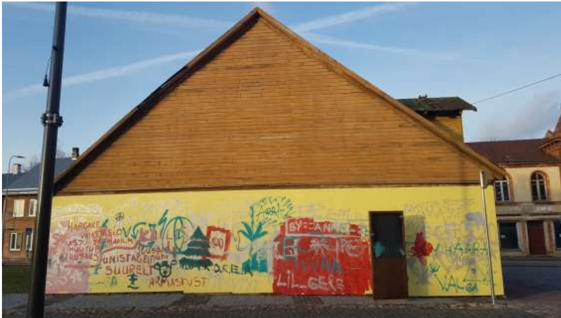
Foto 3.3 – Vaade lõunafassaadile. (22.01.2020) Algupärane poolkelp asendatus viilkatusega. Taastada poolkelp olemasolevate konstruktsioonide eeskujul.
