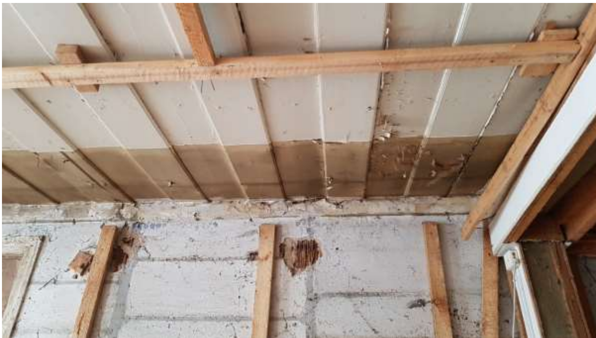
Foto 3.39 – (26.05.20) säilinud sepanaeltega kinnitatud profileeritud laelaudis.
