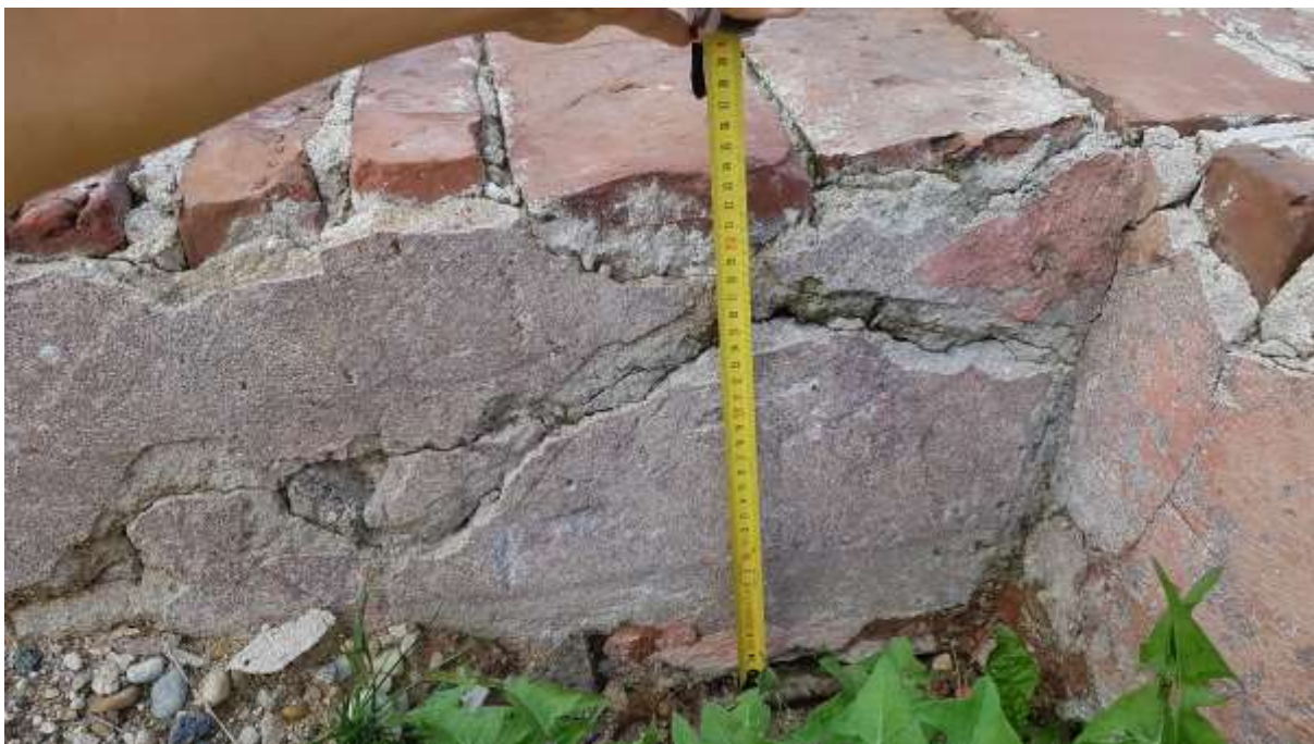
Foto 3.19 - (19.05.20) šurf 10. Põranda kõrgus sokli ülemisest piirist u 25cm.
