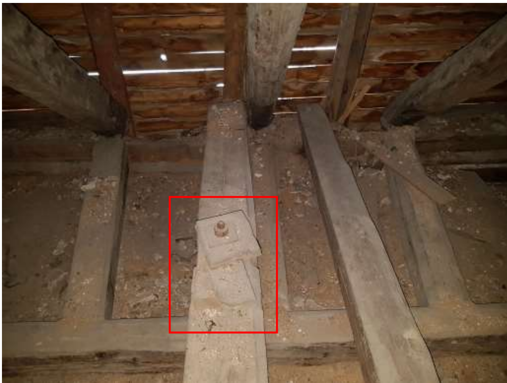
Foto 3.71 – (21.04.20) pennidele toetuv abitala koos ankruga, esimesel korrusel pikiteljel asuva eemaldatud vaheseina ülemise palgi toestamiseks.
