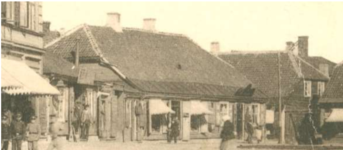
Foto 2.2 – suurendus fotost 2.1 lõunapoolsel osal näha valgmikaken välisuksel ning päikesevarjud akendel. Eristub räästakarniis ning poolkelbal vihmaveetoru
