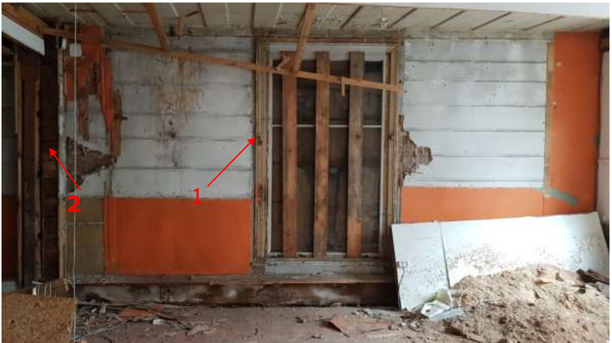
Foto 3.51 - (26.05.20) vaade põhjaseinale. 1 - kihtide alt avanesid 20.sajandi algusest pärinevad aknad. 2 – metallankrutega fikseeritud pikikandeseina otsatapid.
