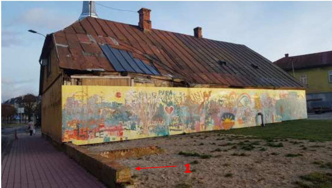
Foto 3.7 – Vaade loodest. (22.01.2020) 1 – lammutusest säilinud juurdeehituse tellisvundament.
