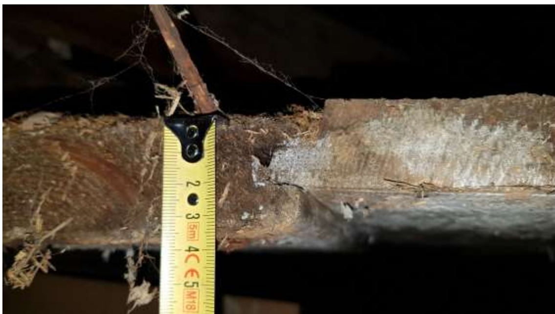
Foto 3.59 – (06.08.20) pööningukorrusel olev laelaudis. Ühtib esimesel korrusel olevaga.
