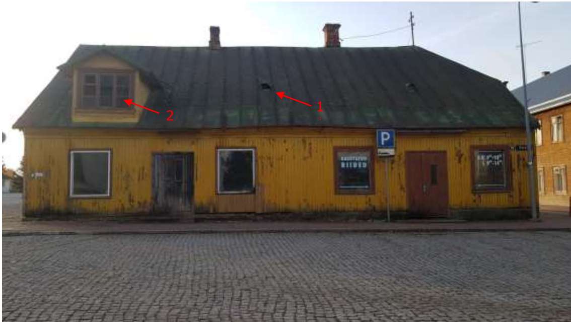
Foto 3.1 – Vaade esifassaadile idas. (22.01.2020). Olemasolevad avad pole algupärased. 1 – algupärane katuseuugi asukoht.
