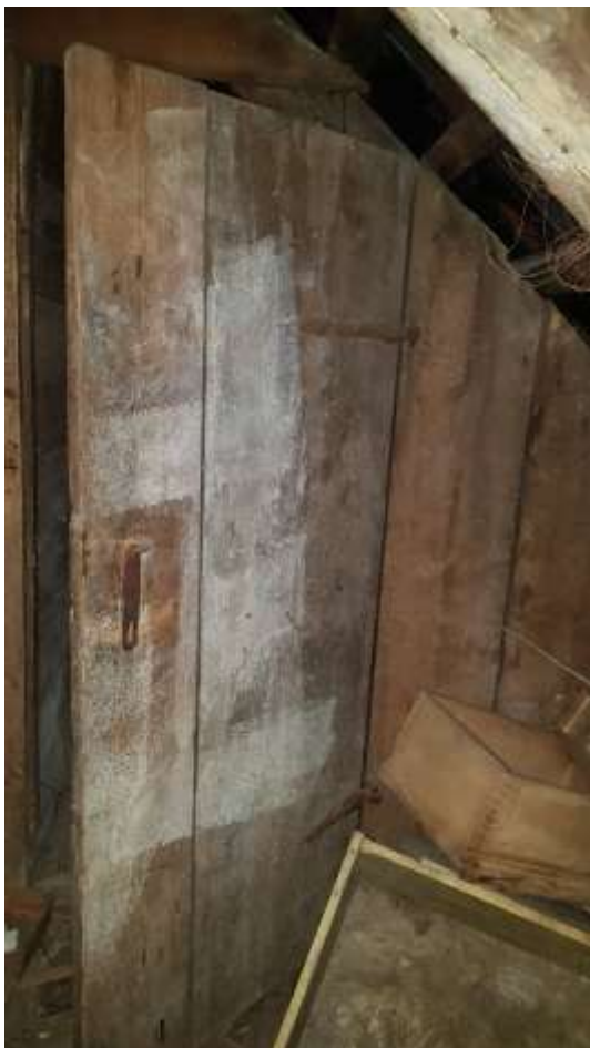
Foto 3.58 –(21.04.20) algupäraste sepistatud uksehingedega panipaiga uks
