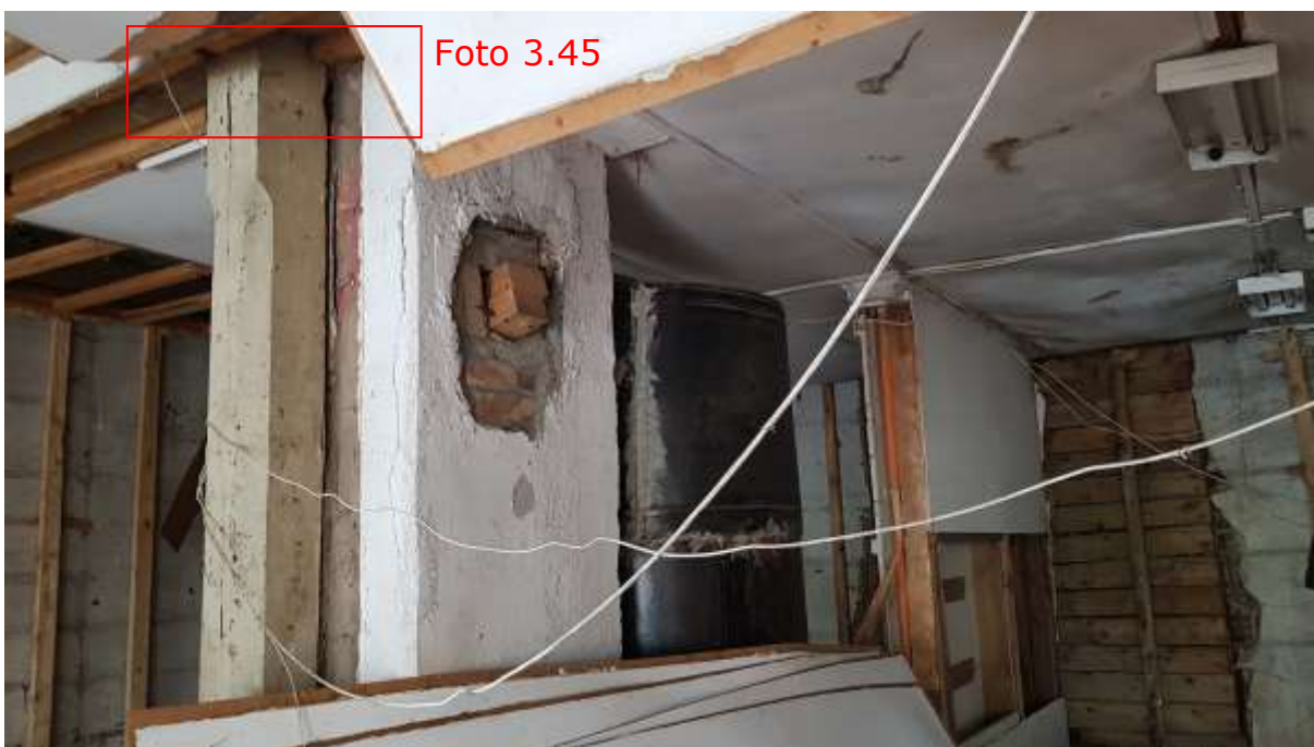
Foto 3.44 - veneaegne plekkahi (1). Pikikandeseina asemele paigutatud profileeritud post.
