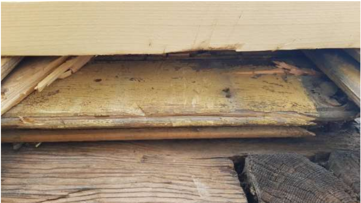
Foto 3.18 – horisontaalne voodrilaud vertikaalse voodrilaua all. (19.05.2020)
