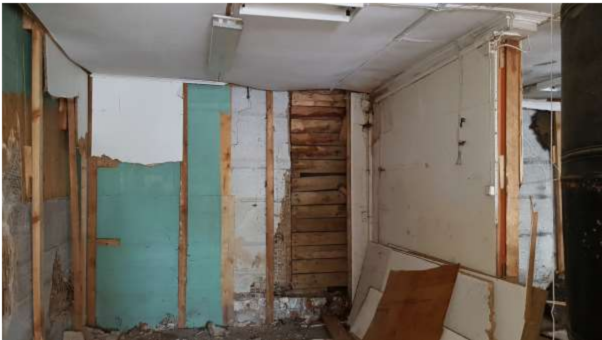
Foto 3.43 - (26.05.20) vaade lääne välisseinale
