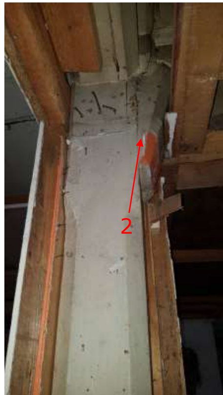
Foto 3.46 - (06.08.20) 1 - jätkatud tala kandevõime on ületatud, tala on pragunenud Foto 3.47 - (06.08.20) 2 - konsooltugi, millele toetub tala.
