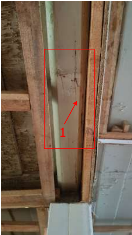
Foto 3.46 - (06.08.20) 1 - jätkatud tala kandevõime on ületatud, tala on pragunenud Foto 3.47 - (06.08.20) 2 - konsooltugi, millele toetub tala.
