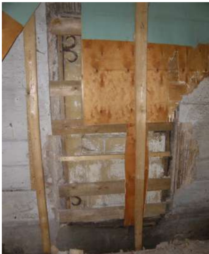
Foto 3.38 - algupärane oinahinge jälgedega tahveluks, mis on trepi ehitusel kinni pandud. (Toivo Erilt, 26.05.2020)
