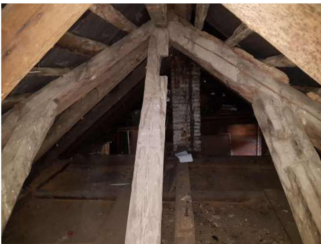
Foto 3.70 (21.04.20) algupärane katusekelba konstruktsioon lõunaseinas.
