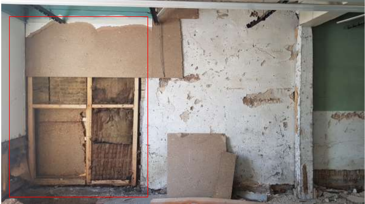
Foto 3.26 - kagunurk on asendatud puitkarkassiga.
