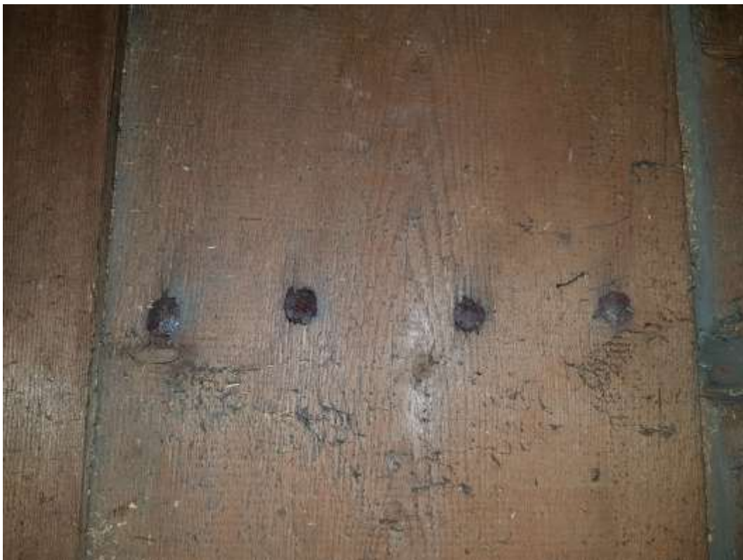
Foto 3.66 – (06.08.20) pööningkorruse perimeetrit kattev sepanaeltega paigaldatud laudis.
