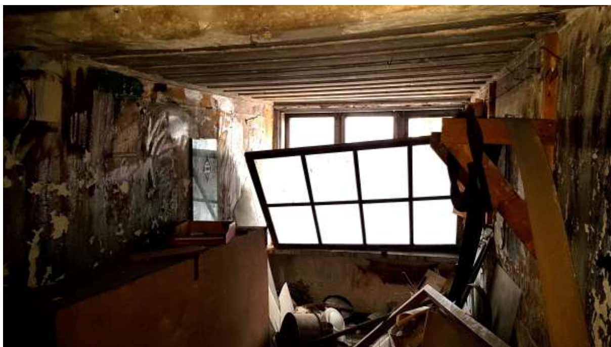
Foto 3.64 – ruum 11 (06.08.20) vaade katuseärkli aknale A-7. Aken on eest kukkunud ning kogu ruumi täidavad jäätmed.
