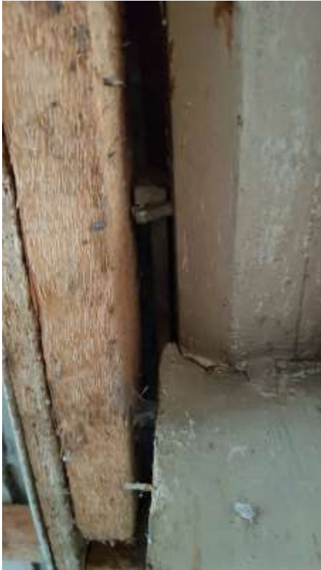
Foto 3.45 - (06.08.20) Postile toetuvat tala on jätkatud.
