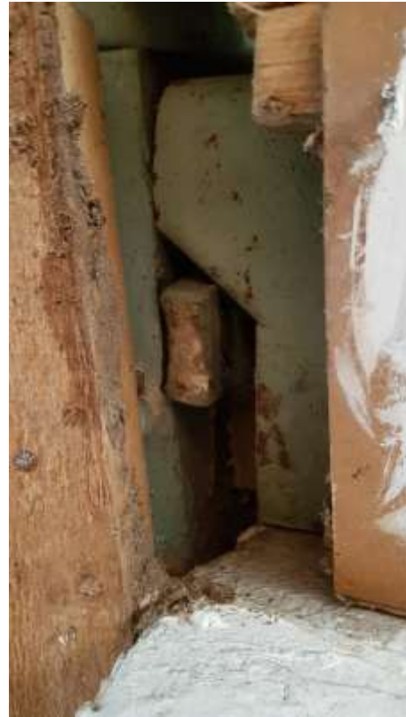
Foto 3.45 - (06.08.20) Postile toetuvat tala on jätkatud.
