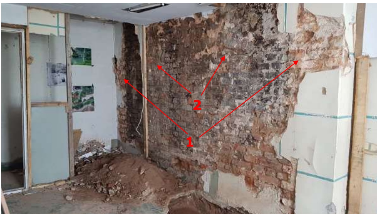
Foto 3.33 - (26.05.20) 1 - lammutatud vaheseina jälg. 2 - kinnimüüritud kaaravad
