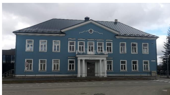
Foto 3.10 Vaade Kõrveküla Põhikoolile
