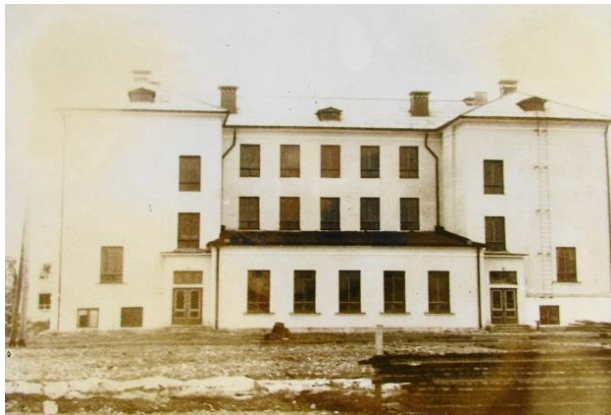
Foto 3.1 Kallaste Keskkooli tagafassaad [69]
