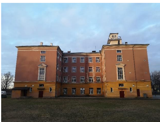
Foto 3.12 Vaade Tartu Kroonuaia kooli tagafassaadile
