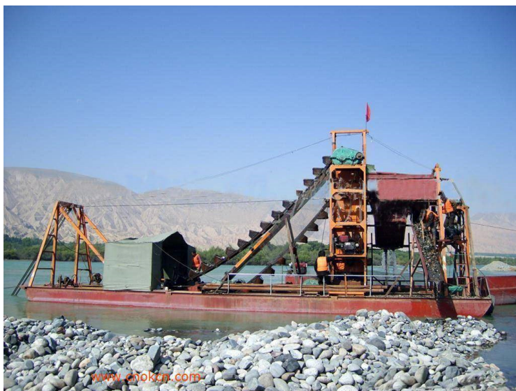
Joonis 3. Paljukopiline süvendaja süvendamistööl
