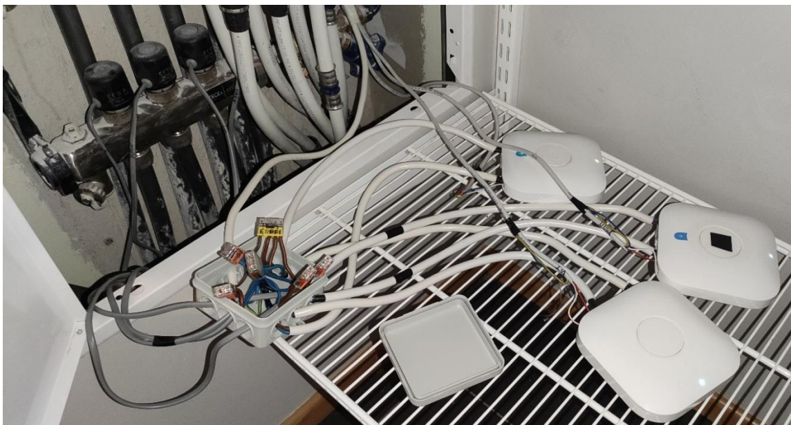
Joonis 2.1 Nutikate termostaatide paigaldamise tööprotsess
