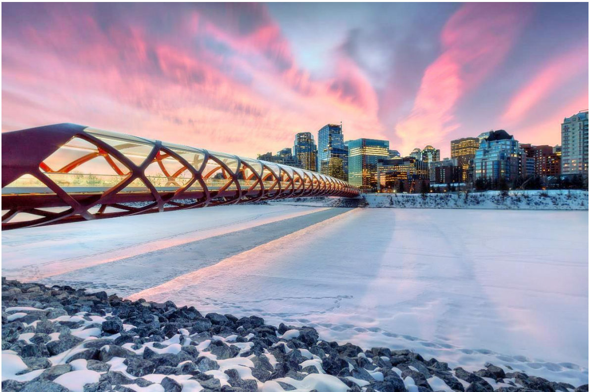
Joonis 4.5. Peace Bridge, Calgary, Kanada
