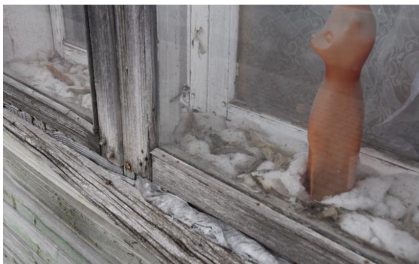
Joonis 3.3.1 Akende soojapidavuse parandamismeetodid
