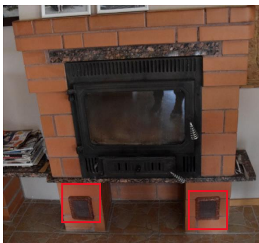
Joonis 3.3.2 kamina õhuvajaduse saavutamine
